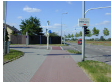
Bild 4: Getrennter Geh- und Radweg entlang der Bürstadter Straße
