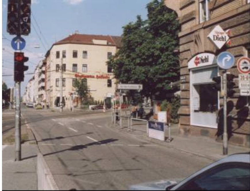
Bild 5: Zufahrt der Neckarstraße-Süd mit missverständlicher Markierung und falsch platziertem Wegweiser
