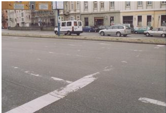
Bild 4: Verschlissene Haltlinienmarkierung
