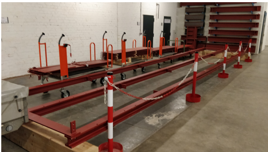
Abbildung 5.5.: Unterkonstruktion der Brücke
