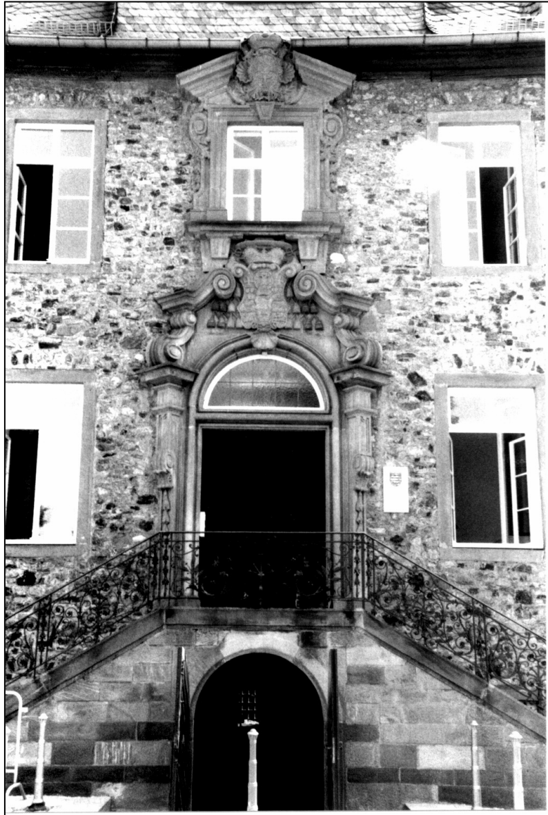
125. Portal mit sich über zwei Geschosse erstreckenden Aufbau
