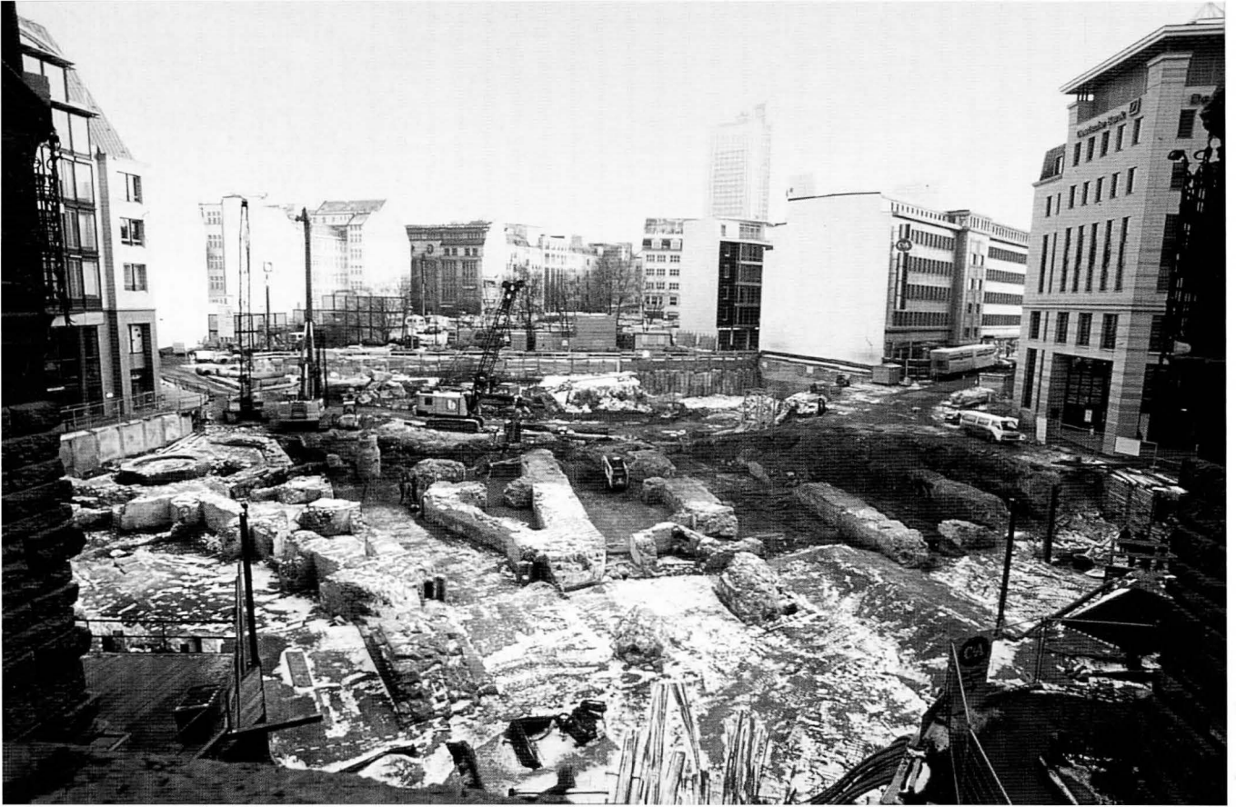
Abb. 27. Leipzig. Die freigelegten Mauern des Trotzers. Durchgang mit angrenzenden Räumen.
