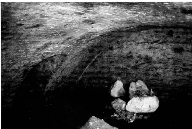
Abb. 29. Leipzig. Wiederentdecktes Kellergewölbe.
