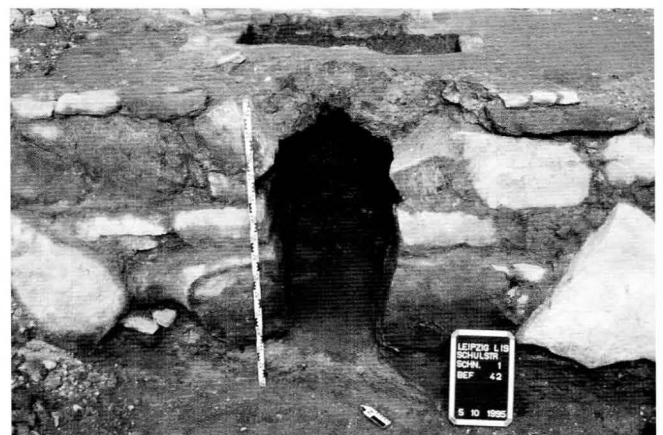
Abb. 35. Leipzig. Grabenmauer, Abwasserschacht.
