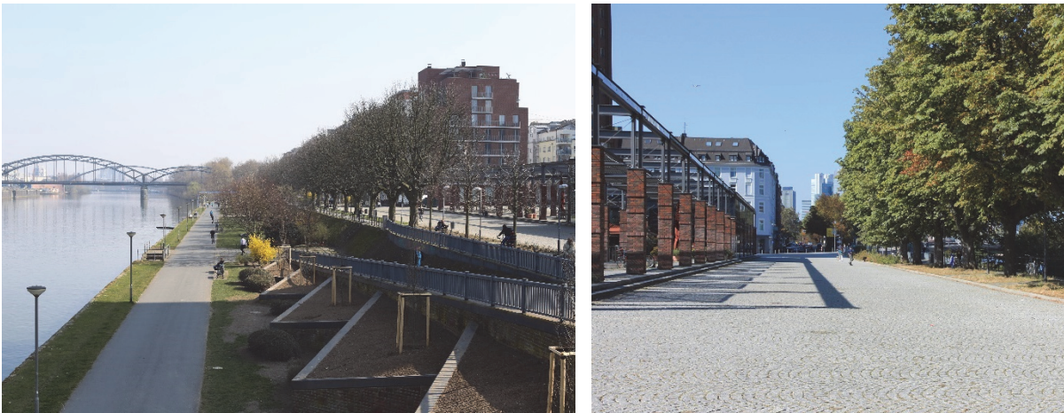
Abbildungen 56 - Tiefkai (links) und Hochkai (rechts) im Bereich des Deutschherrnufers
