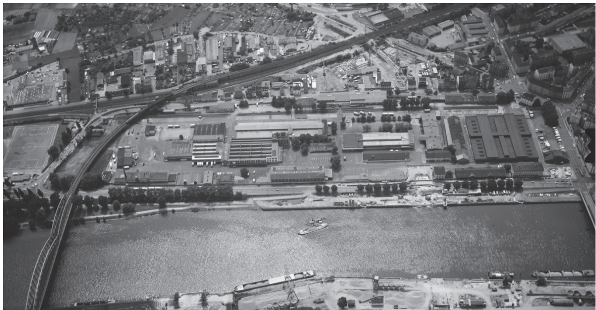
Abbildung 25 - Schrägluftaufnahme des Schlachthofgeländes (1981)
