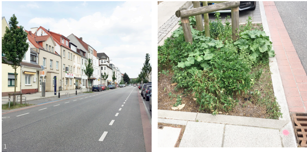
Abb. 30. Gesamteindruck (1) und Versickerungsbeet (2), Klimaboulevard Münchenerstraße, Bremen
