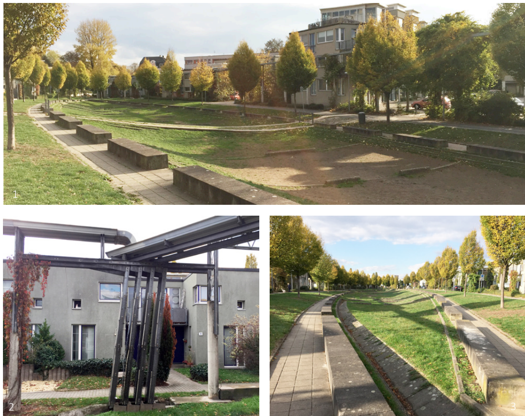
Abb. 17. Zentrale Versickerungsmulde (1), aufgeständerte Rinnen (2), Betonrinnen (3), Siedlung Küppersbusch
