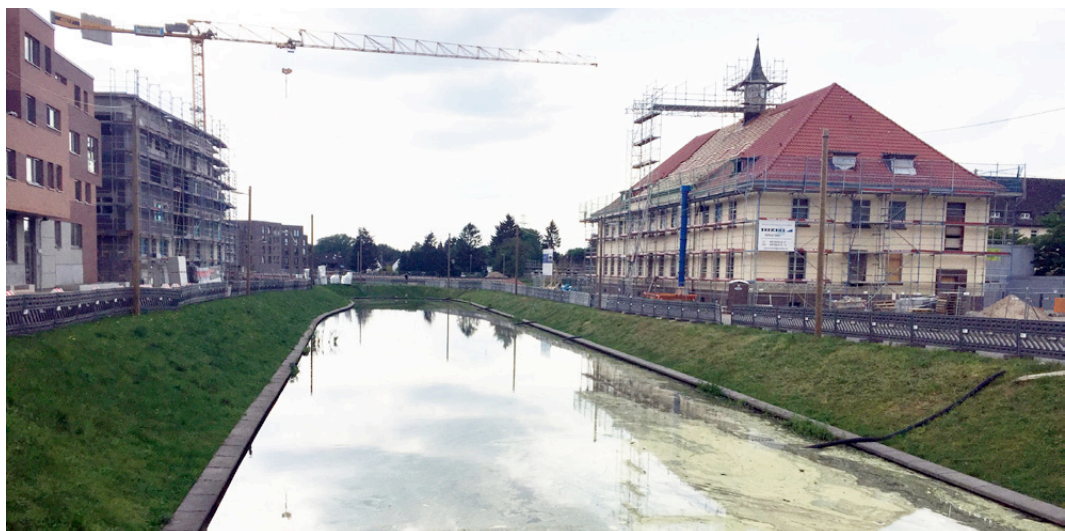
Abb. 23. Zentraler Kanal Jenfelder Au, Baustelle Mai 2018
