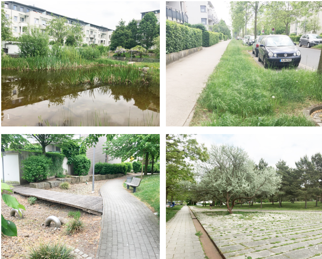
Abb. 18. Speicherteich (1), straßenbegleitende Versickerungsbeete (2), Rückhaltebecken Innenhof (3), zentraler Platz Weistfeld (4), Hannover-Kronsberg
