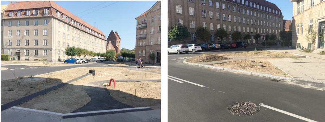
Abb. 52. Bau Bryggervangen/Landskronagade [Bauabschnitt 3], Juli 2018
