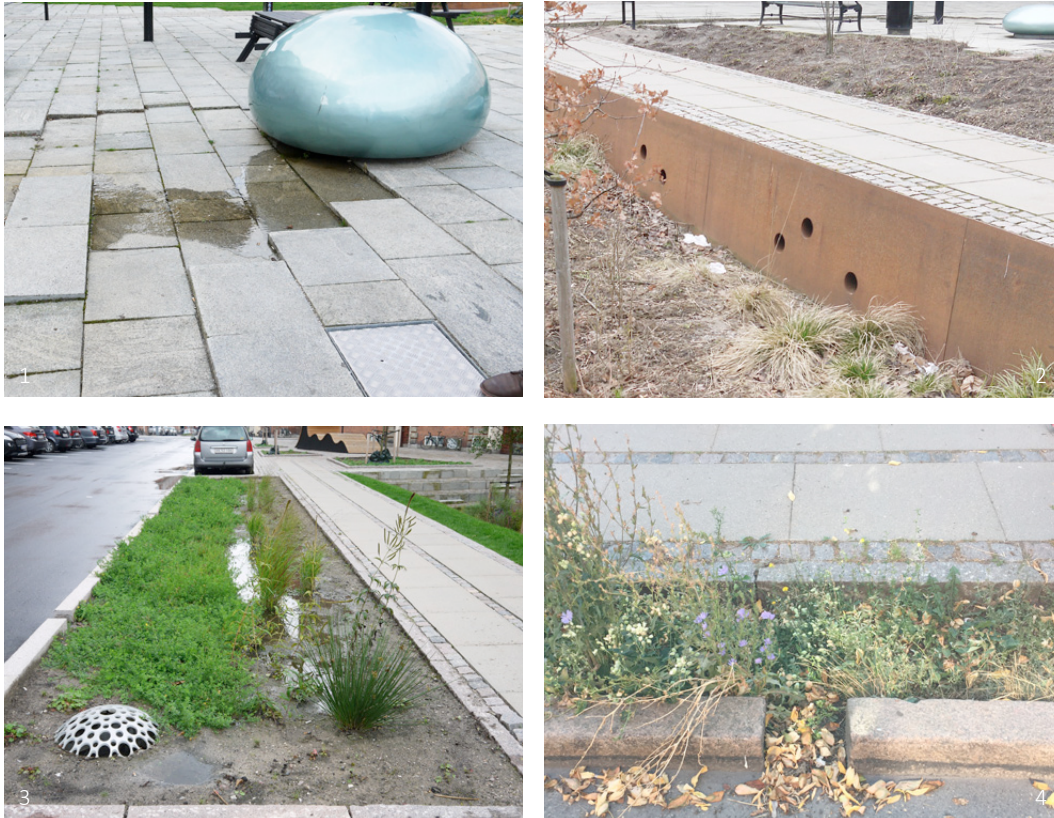
Abb. 67. Elemente Regenwassermanagement: Fußpumpe an „Wassertropfen“ (1), Löcher an Unterkonstruktion Wege (2), straßenbegleitende Versickerungsbeete mit Versickerungsschacht (3), Einleitung/Anpassung Straßengefälle (4)
