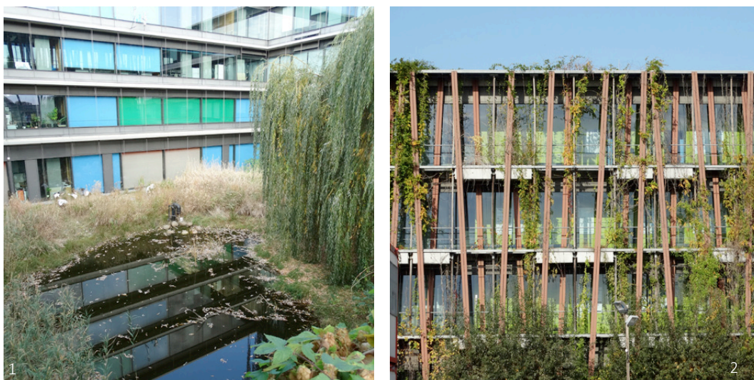
Abb. 27. Speicherteach (1) und Fassadenbegrünung (2), Wissenschaftscampus Berlin-Adlershof (Fotos Sandra Sieber)
