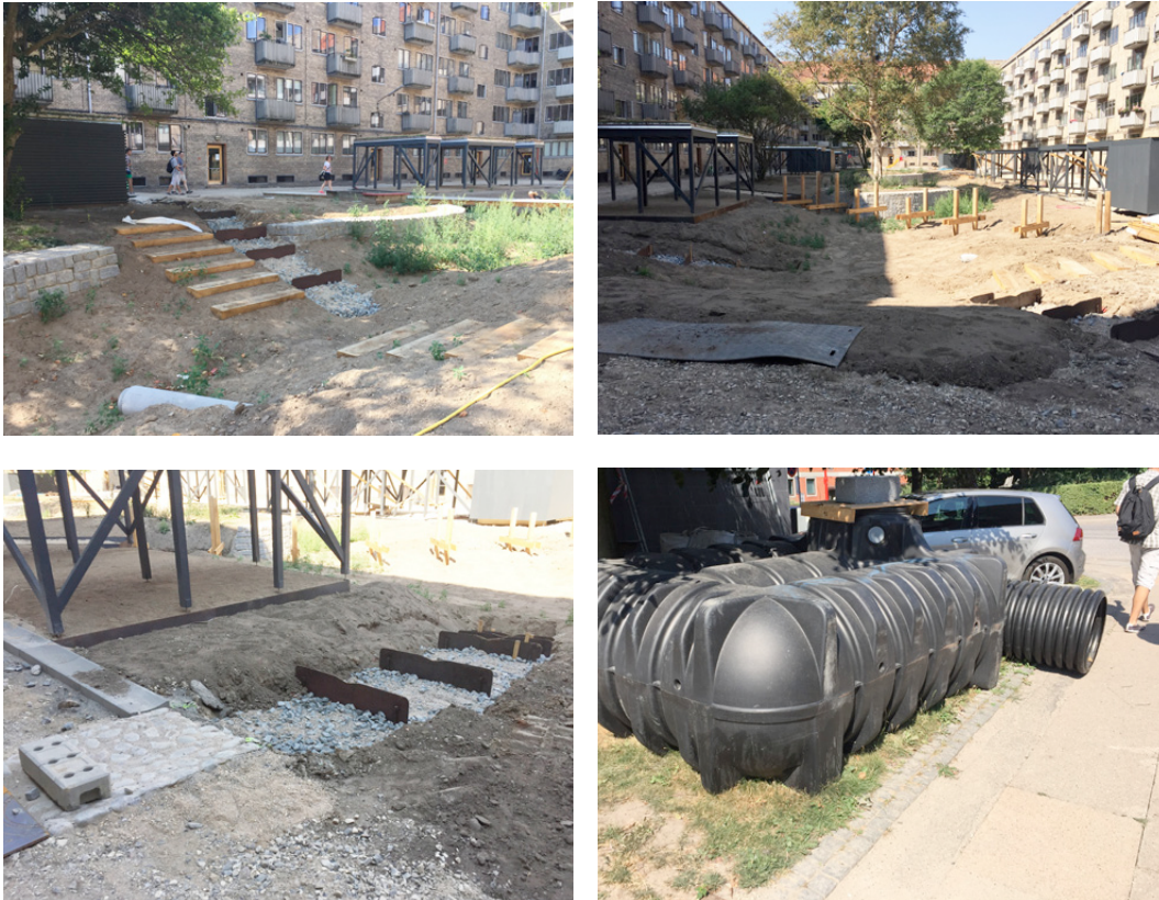
Abb. 56. Baustelle Innenhof Askøde/Vognmandsmarken, Juli 2018
