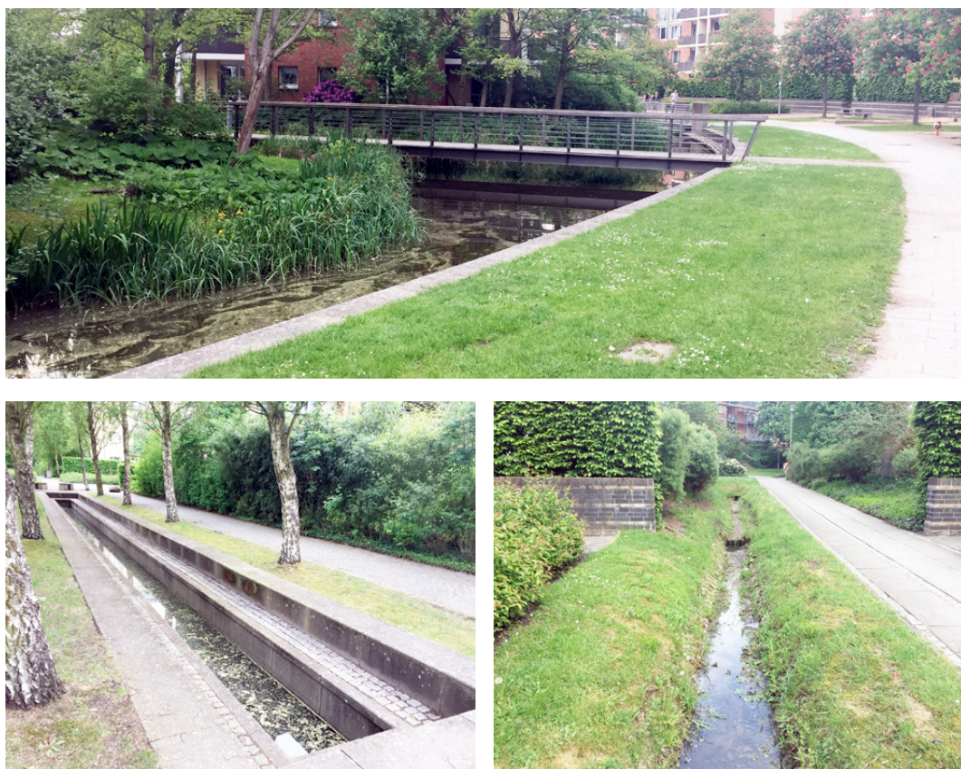
Abb. 19. Kanalsystem Trabrennbahn Farmsen
