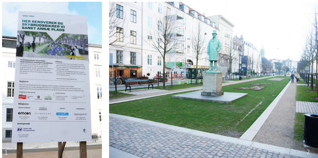
Abb. 46. Skt. Annæ Platz Baustellenschild (1), September 2015 und nach Fertigstellung (2), März 2017
