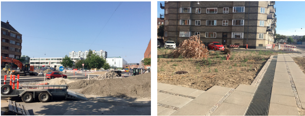
Abb. 51. Bau Skt. Kjelds Platz [Bauabschnitt 1] + Bryggervangen/Victor Bendix Gade [Bauabschnitt 2], Juli 2018
