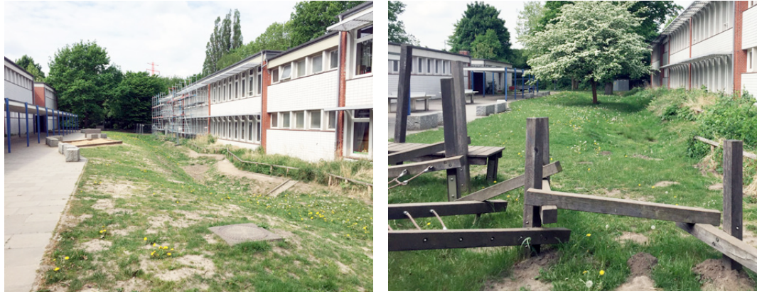
Abb. 29. Versickerungsmulden im Aussenbereich der Grundschule Wegenkamp, Hamburg
