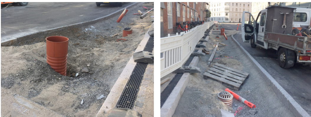
Abb. 53. Bau Bryggervangen/Höhe Ourøgade [Bauabschnitt 4], Juli 2018
