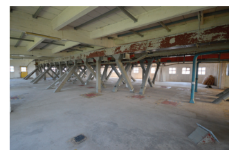
Abb. 90: Verteil- und Füllebene Silo III
