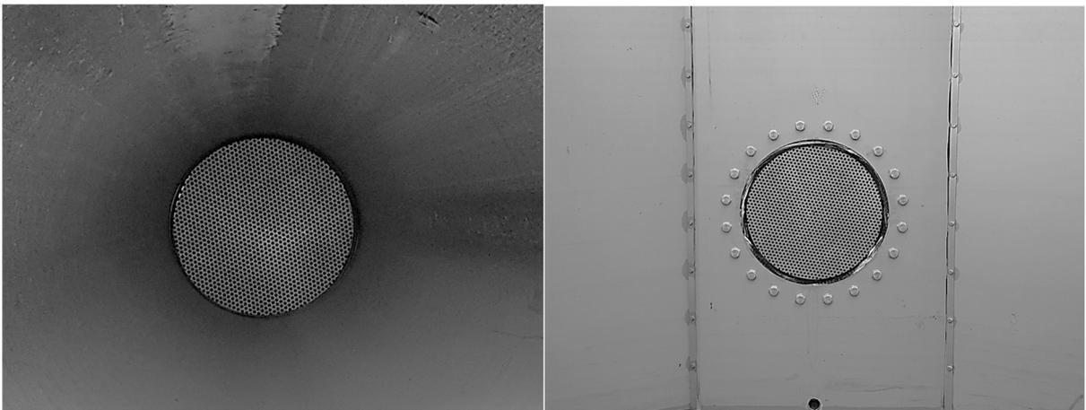
Abbildung 5-23: Blick in die Beruhigungskammer mit Lochblech entgegen der Strömungsrichtung (links) und mit Blick in Strömungsrichtung auf baugleiches Lochblech als Einlaufschutz für den Pumpenzulauf (rechts).
