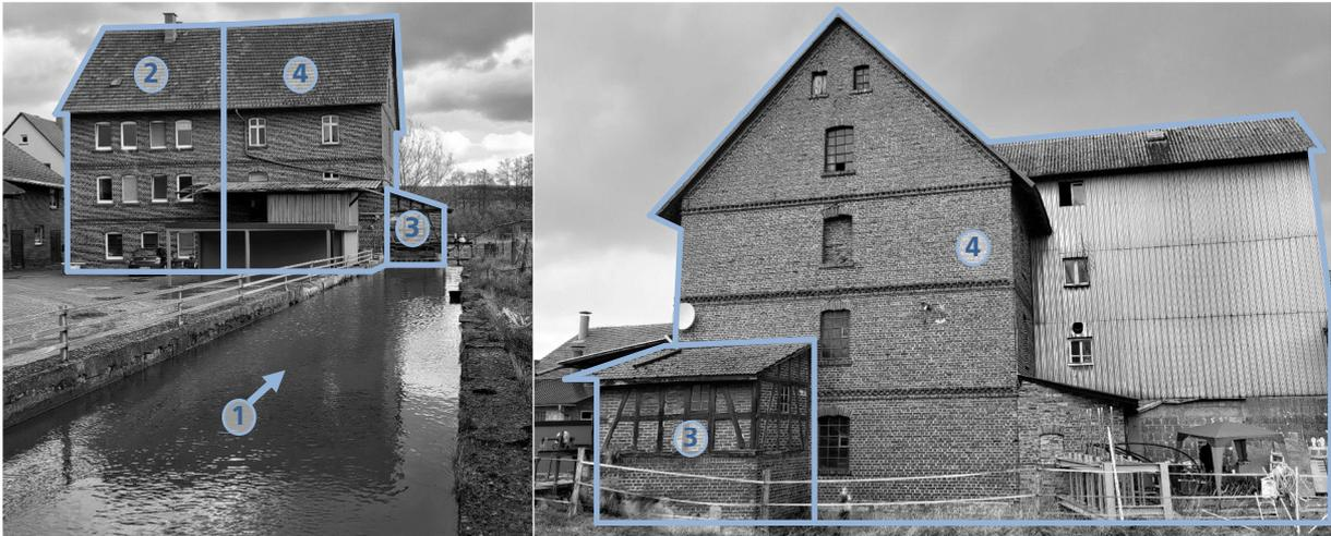
Abbildung 5-82: Blick in Strömungsrichtung auf den Mühlkanal (1) mit dem beheizten Wohngebäude (2) (links) und Blick auf das Krafthaus (3) sowie das unbeheizte Mühlhaus (4) (rechts).
