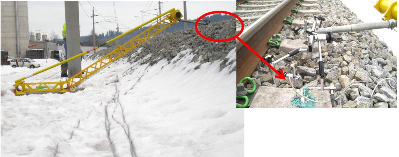
Bild. A. 10: Außerhalb des Gleises fixierte Messbasis
