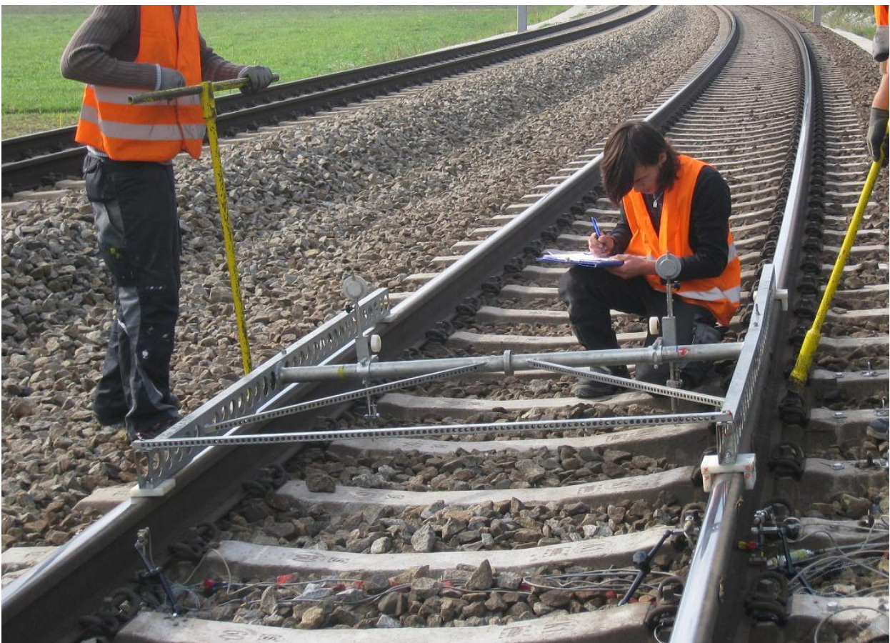
Bild. A. 14: Messeinrichtung der Nullsetzungsmessung
