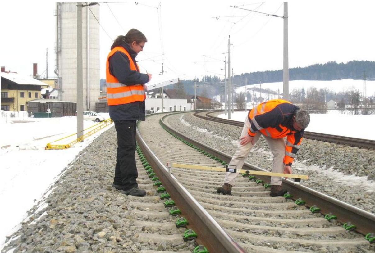
Bild. A. 12: Messung der Spurweite und der Überhöhung des Gleises
