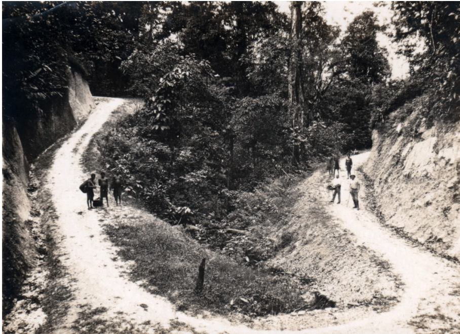
16 Der Weg zum Sattelberg, hier schon zur Straße ausgebaut.
