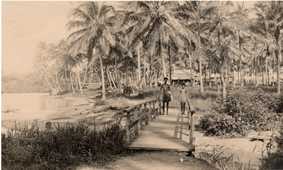
15 Der Weg von Finschhafen zum Anlegeplatz Maneba.
