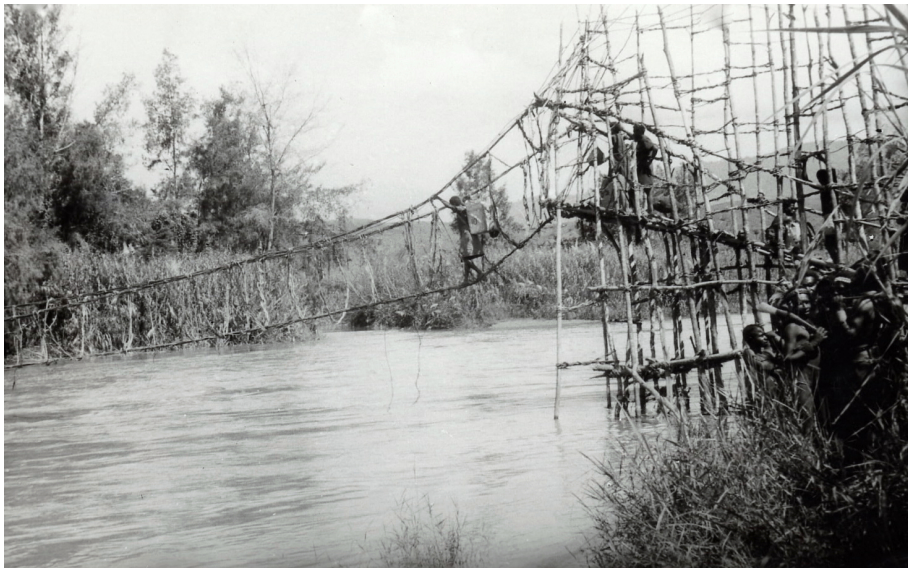
20 Der »Brückenkopf« einer Brücke über den Waghi-Fluß (Mai 1934).
