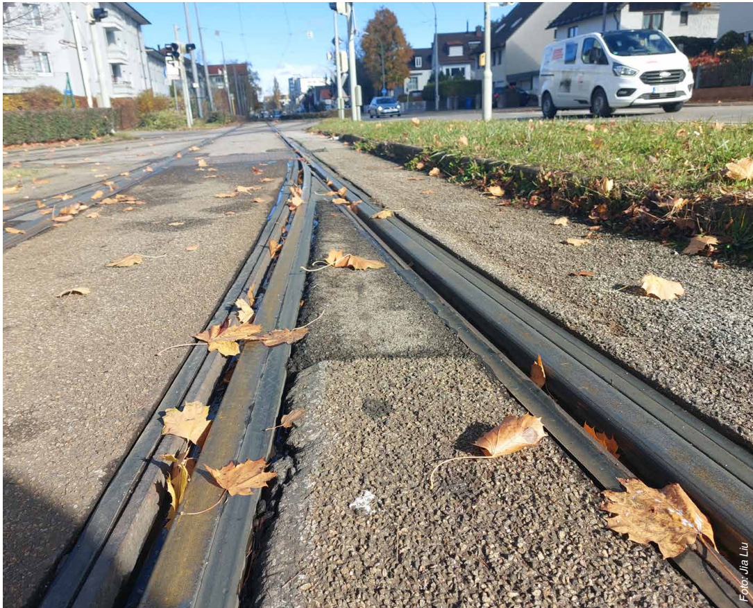
Die Verbindung der Verkehrswege von Schiene und Straße ist eine besondere Herausforderung
