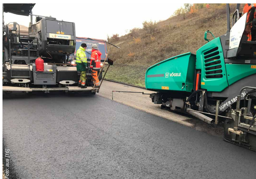
Einbau mit einem Sprühfertiger
