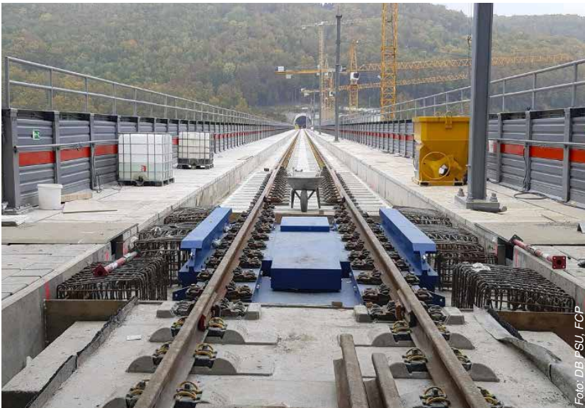
Gleis-Tragwerk-Interaktion: Schienenauszug auf der Filstalbrücke
