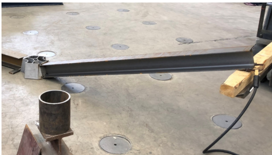
(c) Ausrichten der Träger
