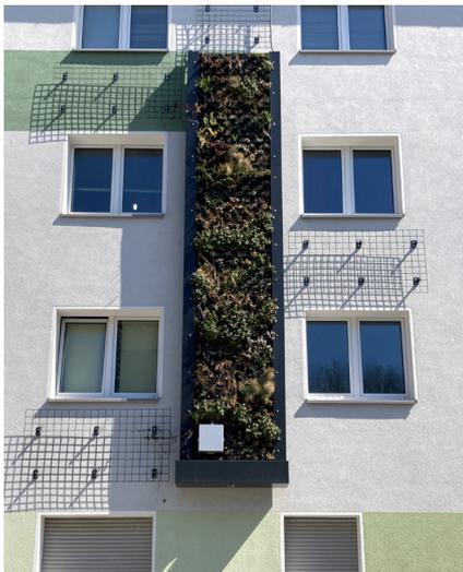
Da der Bereich im Erdgeschoss des Gebäudes nicht begrünt wurde, konnte auf Vergleichsmessungen in unterschiedlichen Höhen verzichtet werden. Mit der Montagehöhe von etwa 3,20 m über Bodenhöhe befinden sich die Sammler in der nach VDI 2119:2013 vorgesehenen Montagehöhe. Die Montage der Sammler wurde am 31. Mai 2021 ausgeführt.
