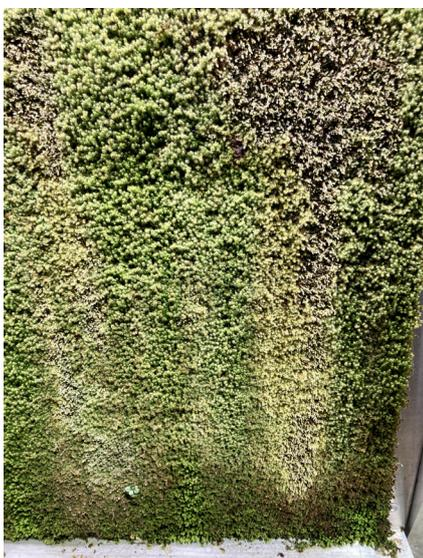
Abbildung 116 (oben): Bildung von Fäulnisprozessen aufgrund von Überbewässerung im unteren Bereich.
