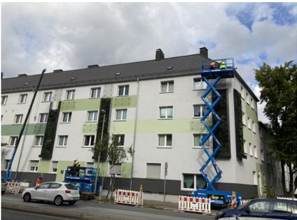
Abbildung 61: Montage der Fassadenbegrünung Gladbecker Straße. Paralleles Arbeiten mit mehreren Hebe-Arbeitsbühnen.
