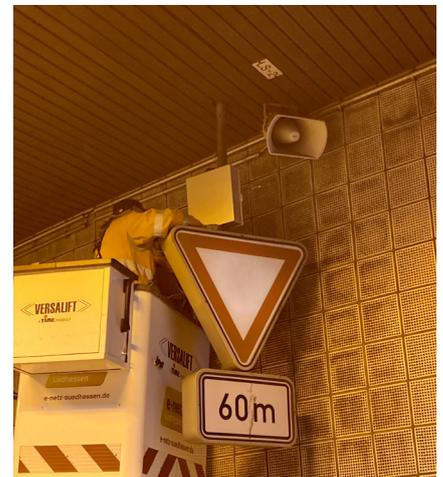
Abbildung 55: Montage des Messgerätes HDD172 im Eingangsportal „Rheinstraße“ des Citytunnels.
