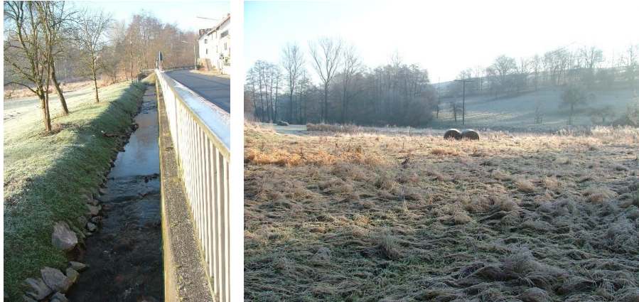
Abbildung 5-14: Uferbefestigung und Begradigung der Kinzig im Januar 2009 bei km 1+200 (Blick gegen die Fließrichtung; links) und Einblick in das Verfahrensgebiet talabwärts der Pudermühle in östliche Richtung (rechts) (AfB Heppenheim 2009a, o. S.)
