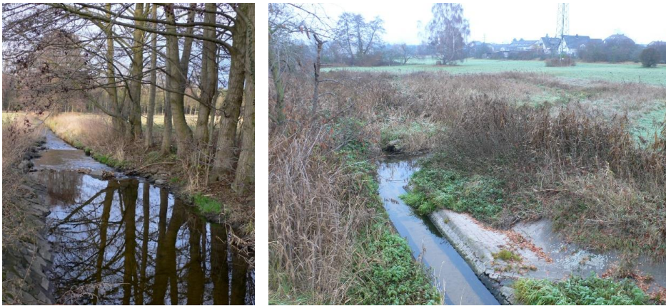
Abbildung 5-6: Uferbefestigung und Begradigung der Bieber in der Gemarkung Heusenstamm im April 2009 bei km 7+250 (Blick in Fließrichtung; links) und im November 2011 bei km 7+970 (Blick in Fließrichtung; rechts) (links: Fritz und Goebel 2009, S. 15; rechts: Fritz 2011, o. S.)
