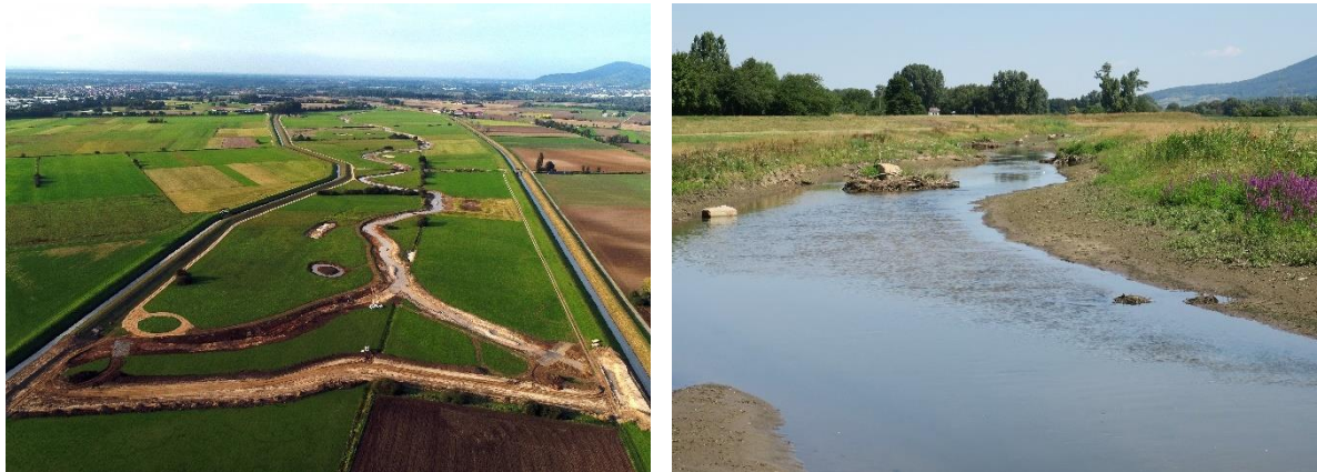
Abbildung 5-13: Modellierung des neuen Gewässerlaufes im Oktober 2017 (Blick in Fließrichtung; links) und Einbau wasserbaulicher Elemente im Juli 2018 (Blick in Fließrichtung; rechts) (links: AfB Heppenheim 2017a, o. S.; rechts: AfB Heppenheim 2018b, o. S.)
