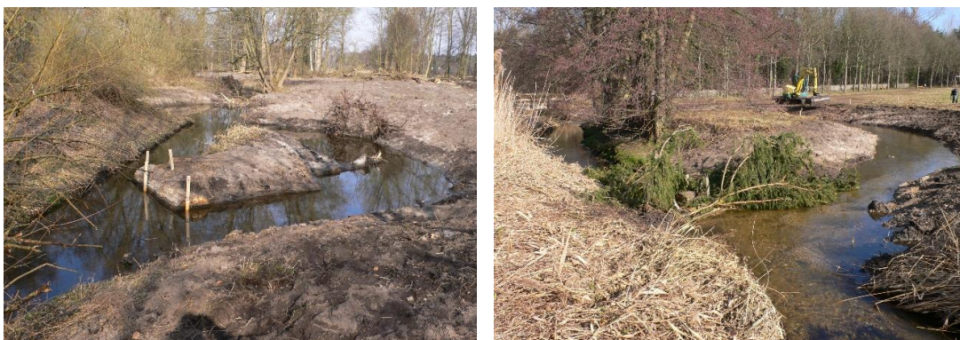
Abbildung 5-9: Umsetzung der Renaturierungsmaßnahmen und Einbau wasserbaulicher Elemente an der Bieber im März 2011 bei km 7+000 (Blick in Fließrichtung; links) und bei km 7+160 (Blick in Fließrichtung; rechts) (Fritz 2011, o. S.)
