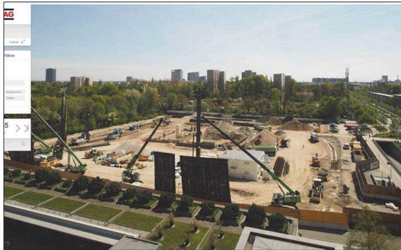
Bild 7 Übersicht über die Baustelle RS76 (STRABAG-Webcam, 2023)
