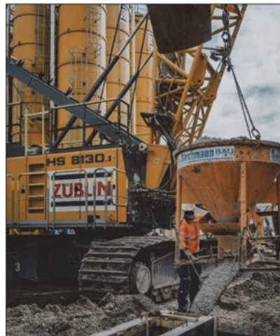
Bild 2 Einbau Geopolymerbeton in Berlin (© ZÜBLIN Spezialtiefbau)
