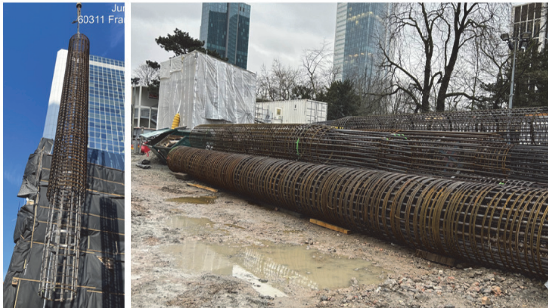
Bild 7 Massiv bewehrte Bewehrungskörbe beim CBT
