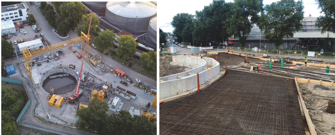
Bild 5 Lastverteilende Betonplatten BE-Fläche Süd
