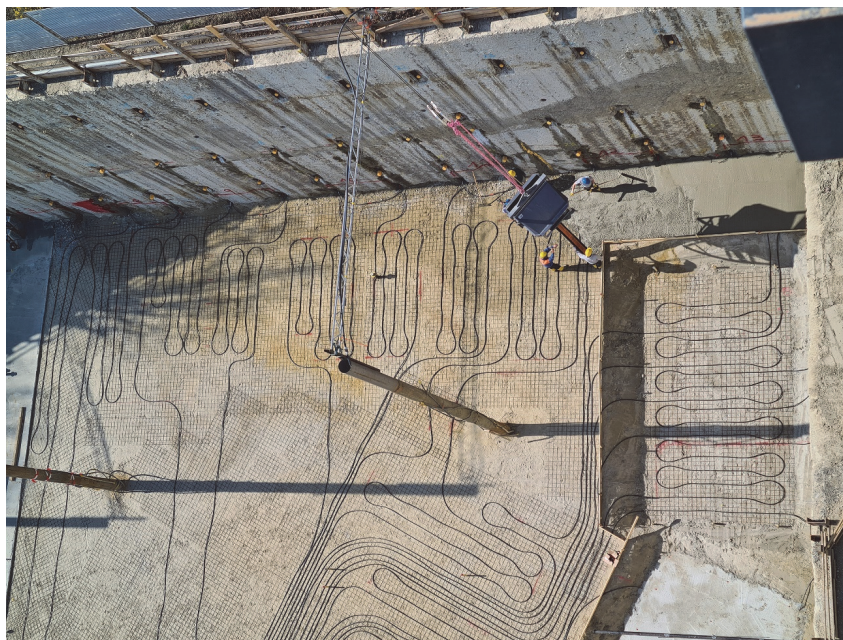
Bild 6 Mehrfach rückverankerte MIP-Verbauwand, mit Auslässen der Geothermieroehre im Bereich der ebenfalls geothermisch belegten Bodenplatte
