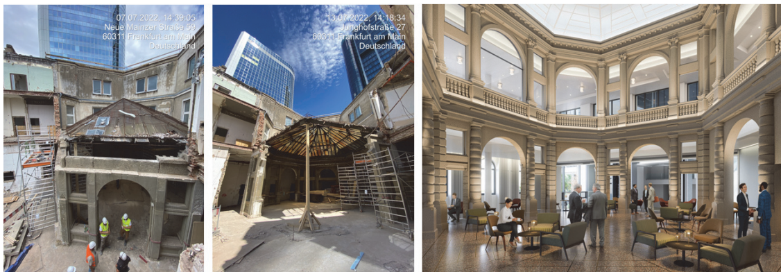
Bild 5 Links: Rückbau der Rotunde, Stand 07.2022 Rechts: visualisiert, Rotunde in Gebäudekomplex integriert (Quelle KSP Engel)
