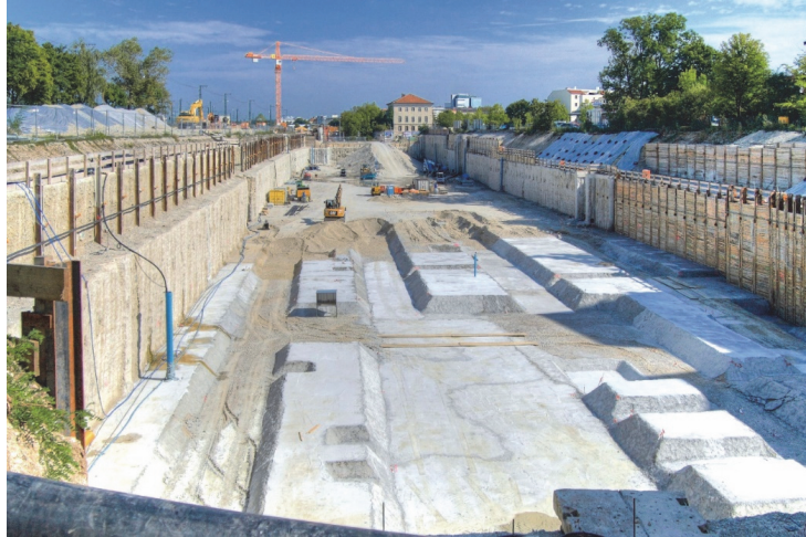
Bild 3 Fertig ausgehobene MIP-Baugrube, München
