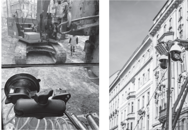
Bild 2 links: Kamera mit Datenlogger und Sensorik in der Fahrerkabine des Bohrgerätes rechts: stationäre Bauüberwachungskamera
