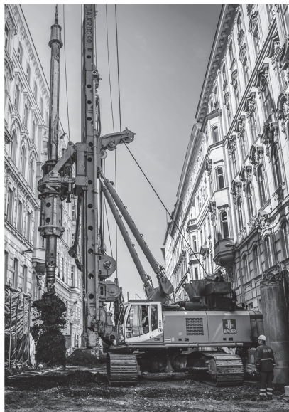
Bild 1 Bauer Bohrgerät mit Datenlogger und DTR Telematik System
