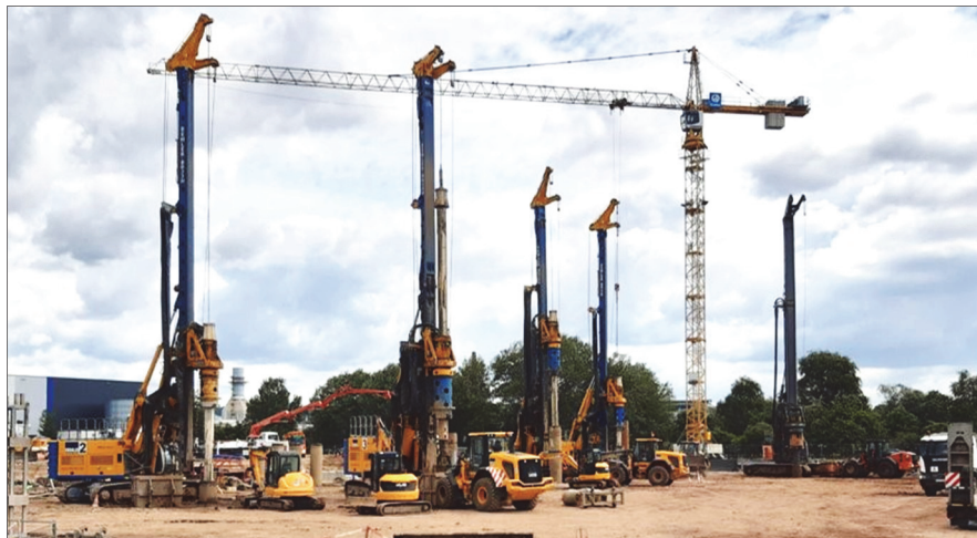
Bild 10 Parallel arbeitende Großbohrgeräte zur Herstellung der Bohrpfähle
