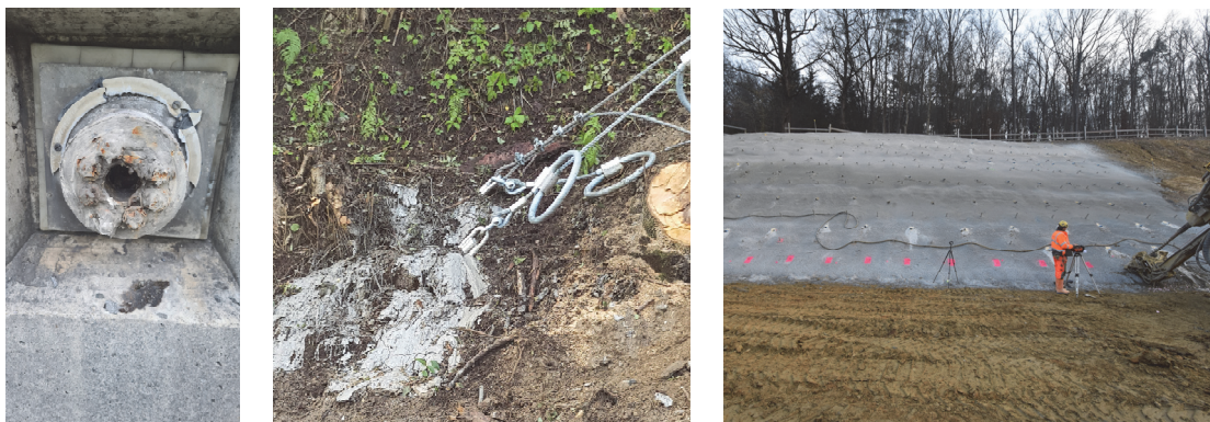
Bild 1 Beispiele für Zugelemente links: vorgespannter Verpressanker, Mitte: Mikropfahl als Fundierung von Schutzbauten, rechts: Ansicht einer Bodenvernagelung
