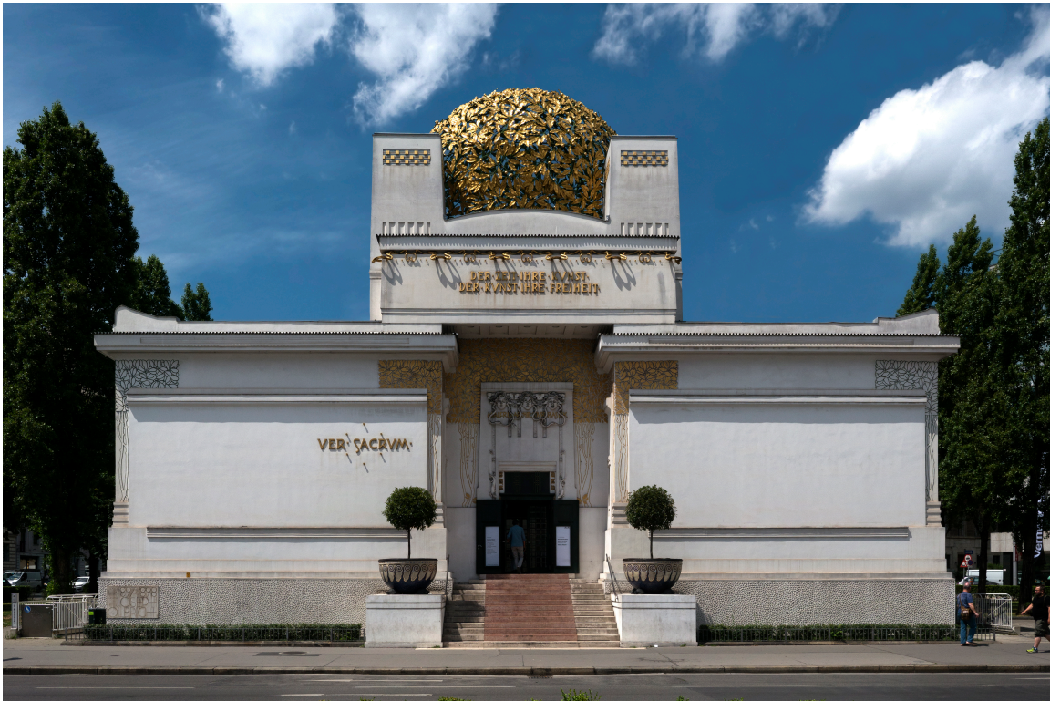
Abb. 1: Joseph Maria Olbrich, Ausstellungsgebäude der Wiener Secession, Gesamtansicht/Vorderseite, Wien 1897/1898 Bildnachweis: Thomas Ledl (Foto), CC BY-SA 4.0, via Wikimedia Commons
