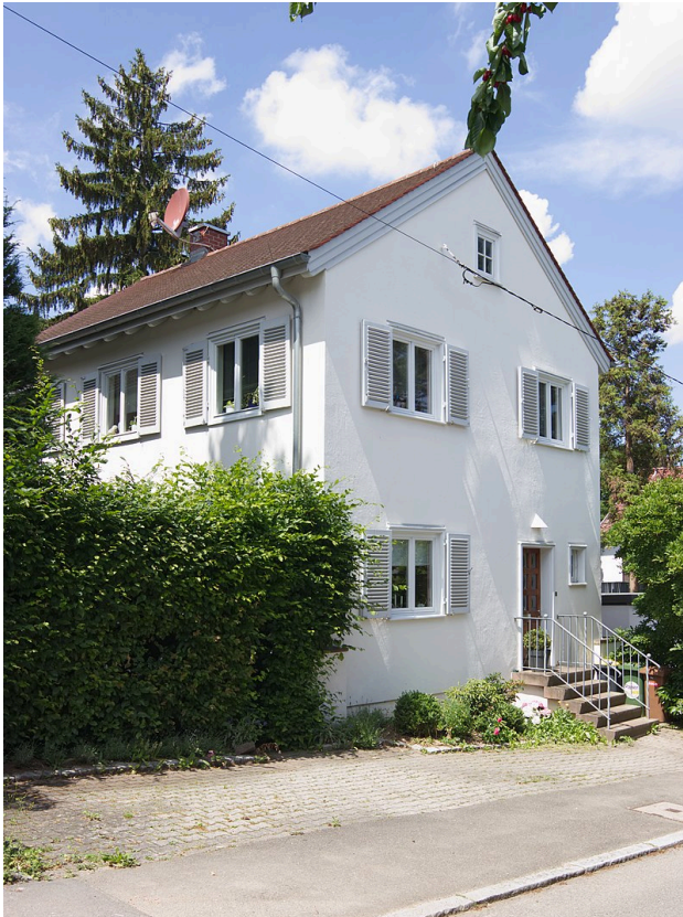
Abb. 17: Hermann Gabler, Haus Nr. 7 der Kochenhof-Siedlung, Stuttgart 1933 Bildnachweis: Zinnmann (Foto), CC BY-SA 3.0, via Wikimedia Commons
