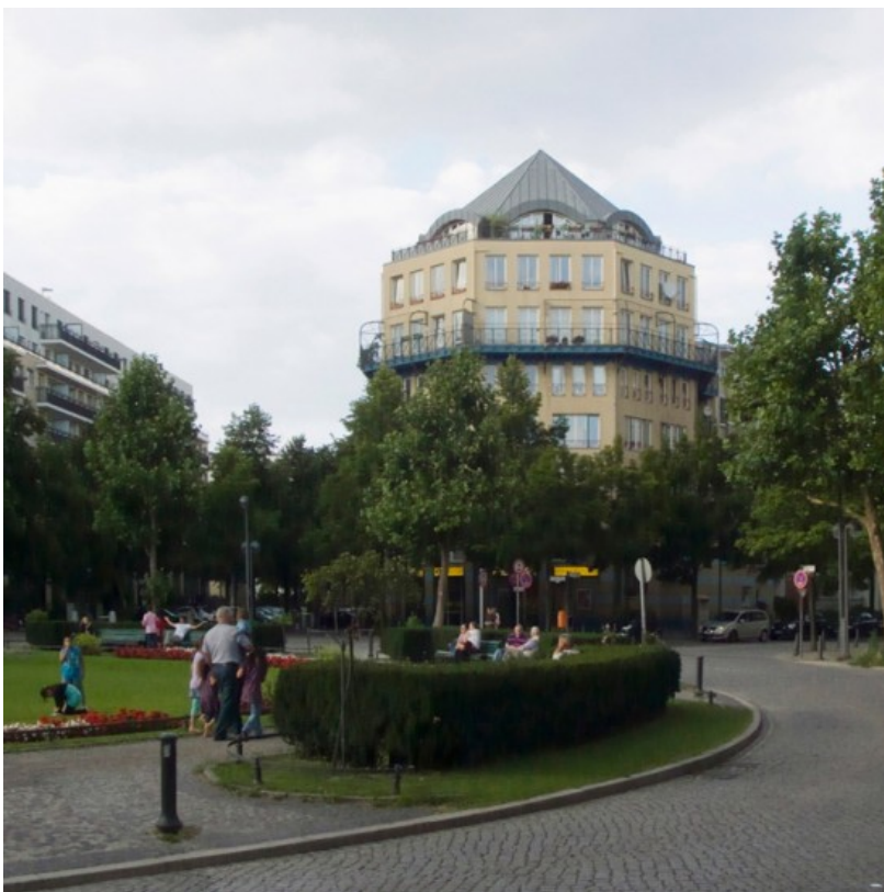
Abb. 38: Rob Krier, Wohn- und Geschäftshaus Prager Straße 11, Motzstraße 90-94, Berlin
