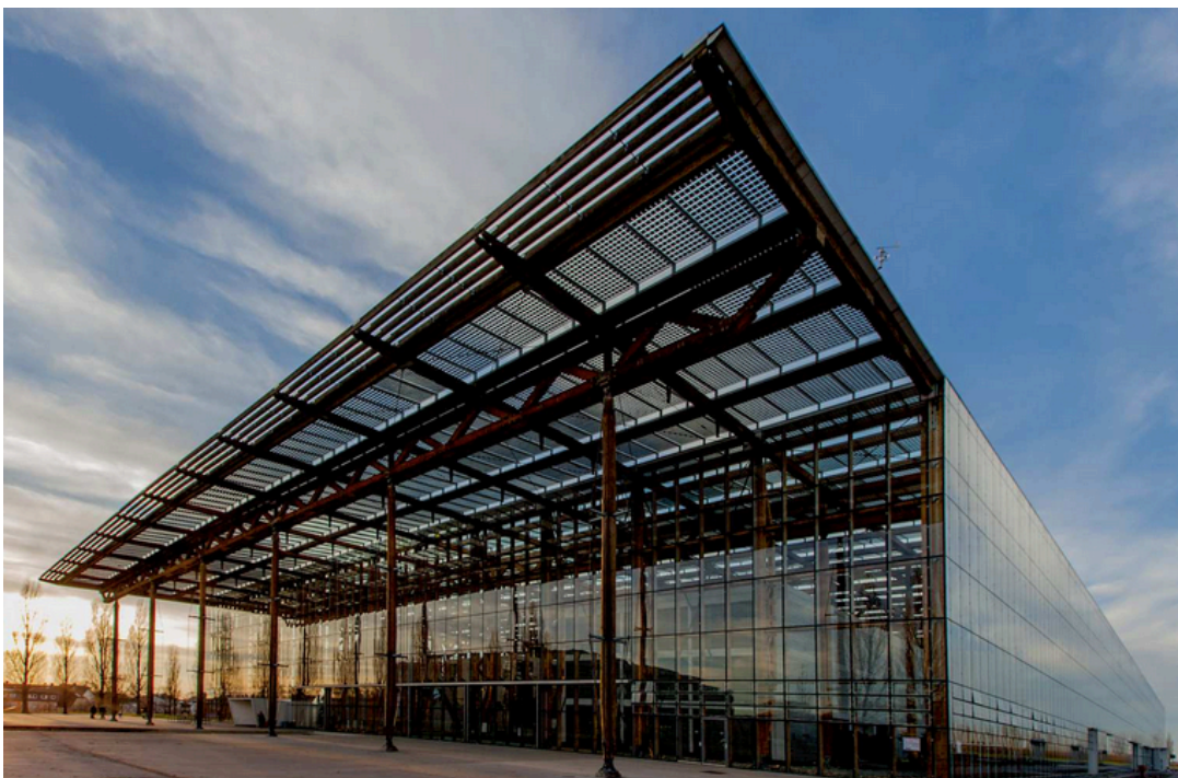
Abb. 54: Stadtteilzentrum und Fortbildungsakademie Mont-Cenis Sodingen, Herne Bildnachweis: https://www.internationale-bauausstellungen.de/geschichte/1989-1999-iba-emscher-park-zukunft-fuer-eine-industrieregion/stadtteilzentrum-und-fortbildungsakademie-mont-cenis-sodingen-herne-eine-brache-wird-stadtteilzentrum-und-ener/ , aufgerufen am 4.11.2021
