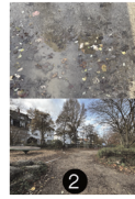
2 Die Wege sind teilweise durch unbelastetes Material rutschig und gerade bei Regenwetter für Rollstuhlfahrer schlecht befahrbar. Auch der angrenzende Spielplatz im Vorbereich des Schwimmbads ist nicht inklusiv gestaltet.
