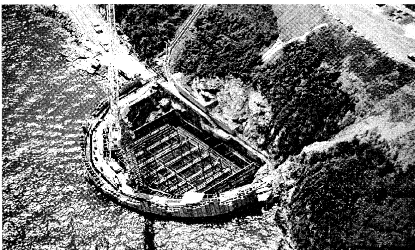
Bild 9 Fundamentherstellung Tsing-Yi Tower
