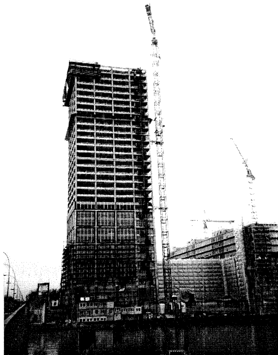
Bild 9 TREPTOWERS - Bauwerk nach Rohbauende im Februar 1997
