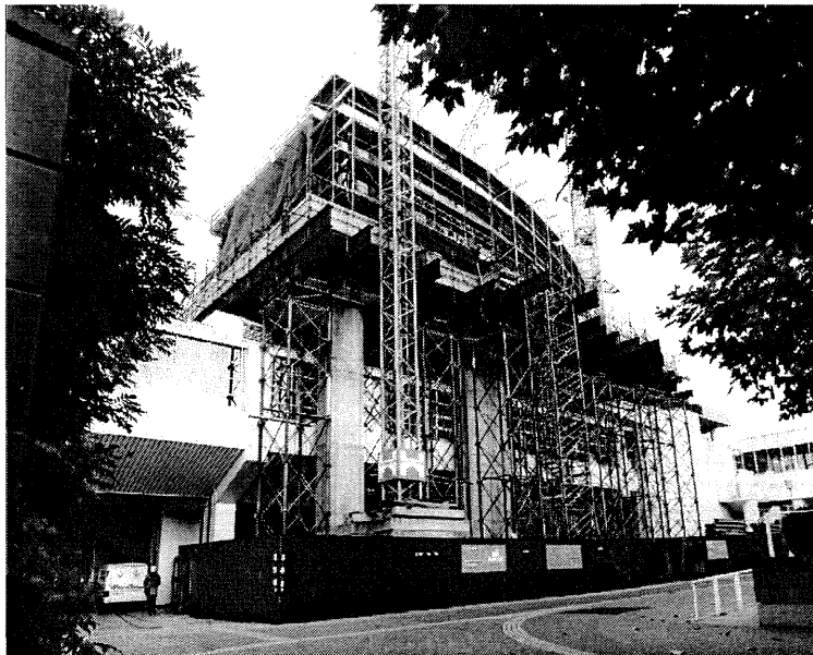
Bild 7 Brückenüberbau über die Via Mobile im Bauzustand
