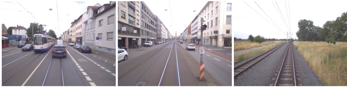
(a) Straßenbündiger Bahnkörper
