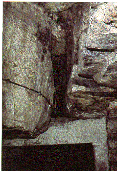
Abb. 3.2: Zu Spalten erweiterte Klüfte in einem Stollen im Zechsteinkalk unterhalb des Schloßberges der Heidecksburg (aus HEISE & SCHLEUSSNER, 1993).
