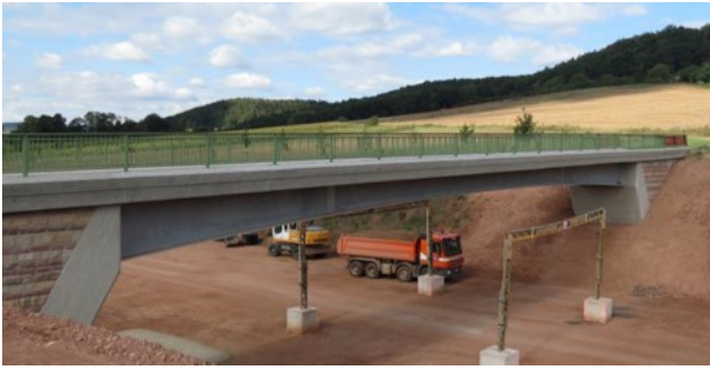
BILD 1 Feuerverzinkte Stahlbrücke über die A44 in der Nähe von Kassel [1].
