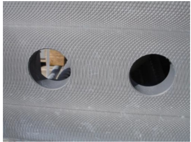
BILD 4 Beispiel einer mechanischen Reibflächenvorbereitung mit nachträglicher Hochtemperaturverzinkung.
