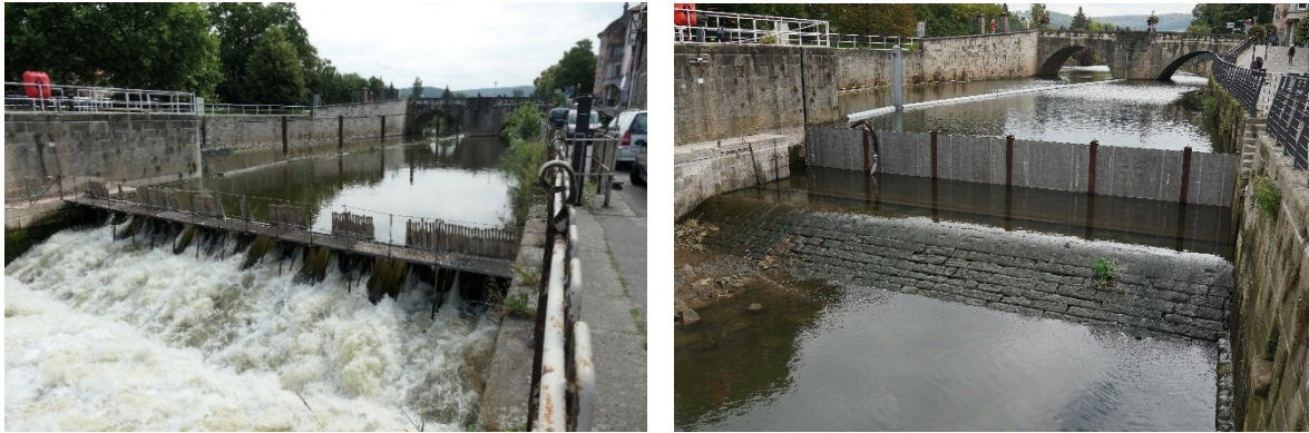
Abbildung 3-3: Ansicht des Nadelwehrs und der Schleuse, links im Betrieb im Jahr 2018 (Berberich, 2018) und rechts im Rahmen der Ortsbegehung im Oktober 2022 (Blickrichtung stromaufwärts)
