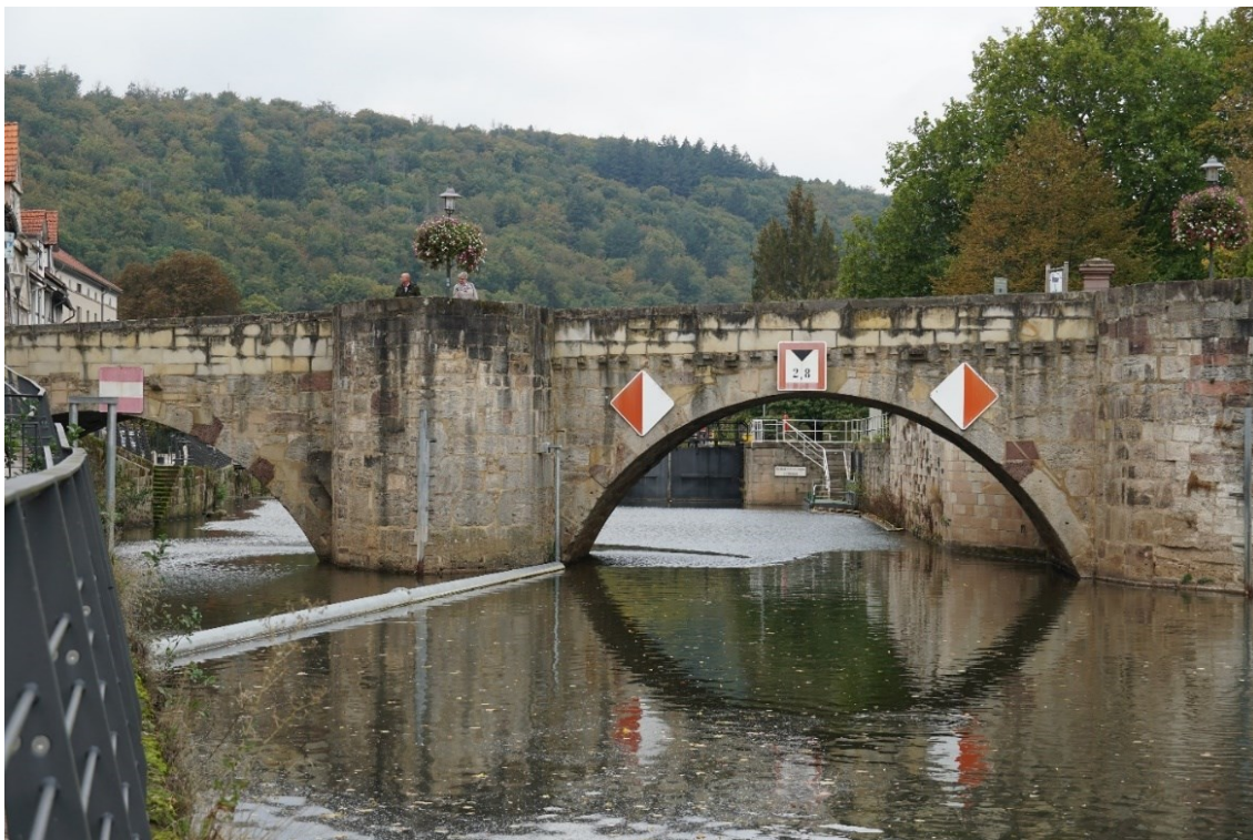
Abbildung 3-4: Ansicht der Werrabrücke und Schleuse (Blickrichtung stromabwärts)
