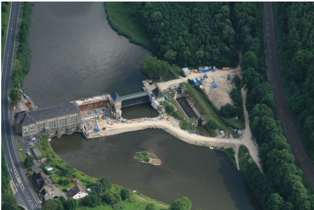
Abbildung 3-13: Laufwasserkraftwerk Werrawerk am Pegel „Letzter Heller“ (Statkraft, 2022)
