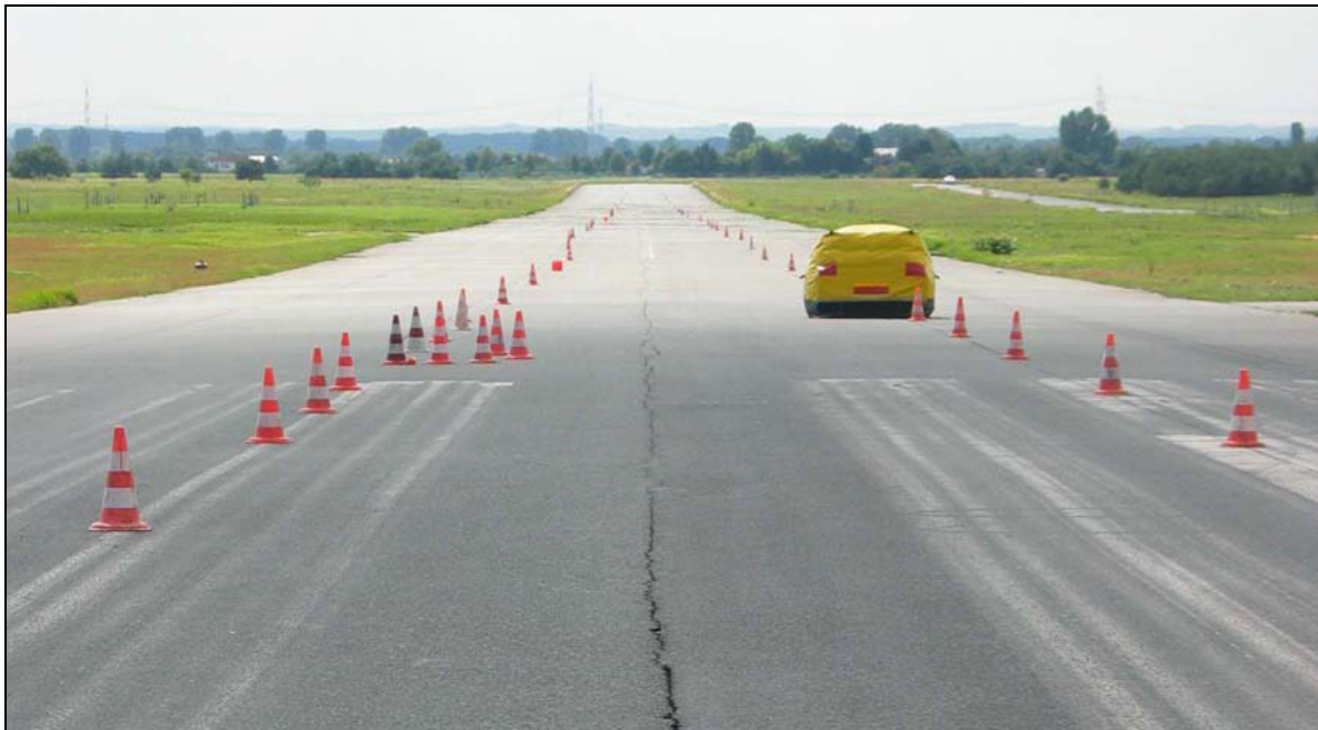
Bild 2: Versuchsstrecke Figure 2: Testtrack
