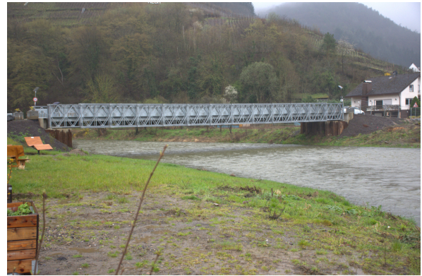
Abbildung 2.10: Zerstörte Brücke im Ahrtal (links) sowie Ersatzbrücke des THW (rechts) in der Nähe von Rech (Ahrtal, Rheinland-Pfalz). (Eigene Aufnahmen im März 2023)
