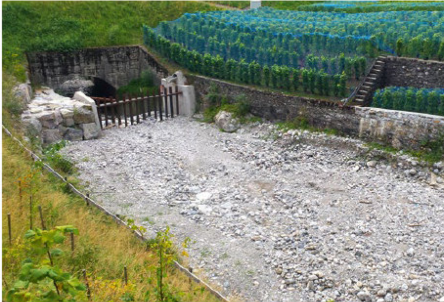
Abbildung 5: Geschiebesammler mit Stabrechen (Schwindt et al. 2017)
