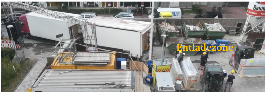
Bild 2: Die Entladezone ist durch Entsorgungscontainer und Material blockiert. Das Lieferfahrzeug kann zur Entladung nicht vollständig in den Projekttraum einfahren und verengt den öffentlichen Straßenraum. Im weiteren Verlauf sind Verkehrsbeeinträchtigungen in der Projekttraumumgebung zu konstatieren.
