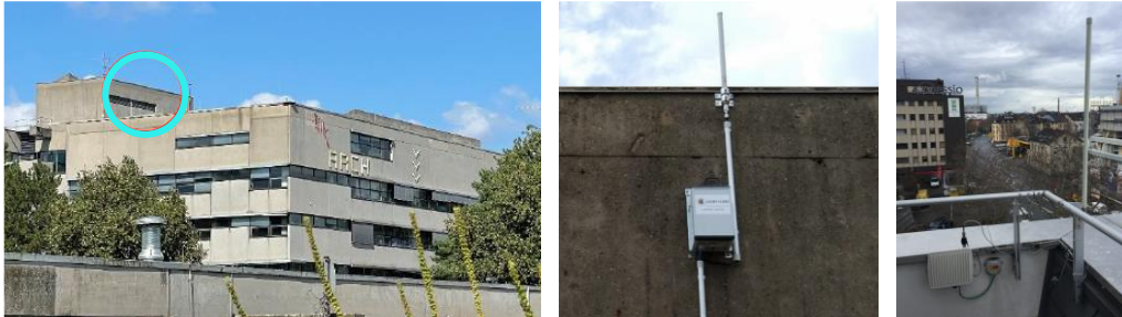
Abbildung 48: Standort der Gateways – Institut für Baubetrieb (links und mittig) 641 und Kooperationspartner (rechts) 642
