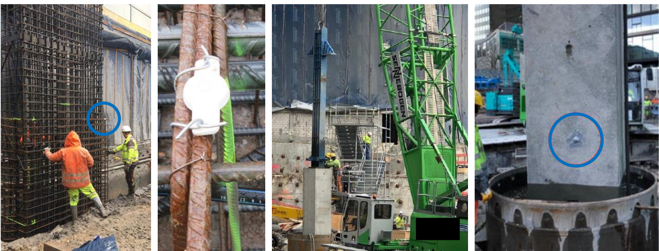
Abbildung 54: Befestigung der Beacons – Bewehrungskorb (links) und Primärstütze (rechts) 649
