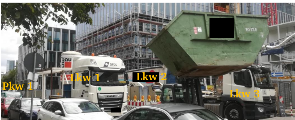
Bild 3: Ein avisierte Transport befindet sich innerhalb der Entladezone (siehe Lkw 2). Ein nicht avisierte Transport und die damit verbundenen Entsorgungsprozesse (siehe Lkw 3) führen zu Verkehrsbeeinträchtigungen in der Projekttraumumgebung. Diese potenzieren sich durch einen weiteren nicht avisierte Transport (siehe Lkw 1). Es sind Verkehrsbeeinträchtigungen in der Projekttraumumgebung (siehe Pkw 1) und im weiteren Verlauf eine Staubbildung zu konstatieren.
