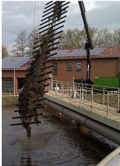
Abbildung 2.2: Verzopfungen durch faserige Stoffe im Belebungsbecken einer Kläranlage (Foto: Tauchbetrieb Richter GmbH).
