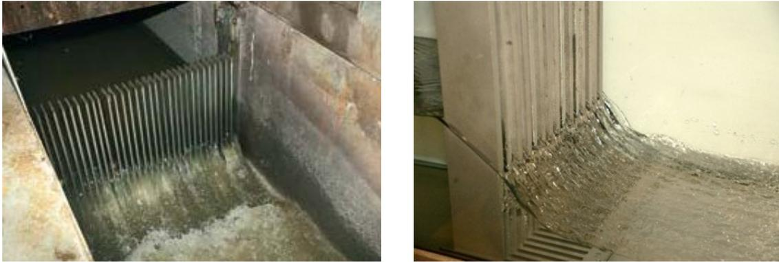
Abbildung 3.19: li. (Grob-)Rechen in der Kläranlage Plettenberg (Foto Ruhrverband) und re. Rechen im Versuchsgerinne jeweils mit rechteckförmigen Rechenstäben.
