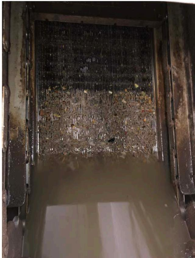
Abbildung 2.4: Harkenumlaufrechen im Zulaufgerinne der kommunalen Kläranlage Saarwellingen. Mit Rechengut belegte, nicht abgereinigte Rechenfläche nach Zulaufabspernung.
