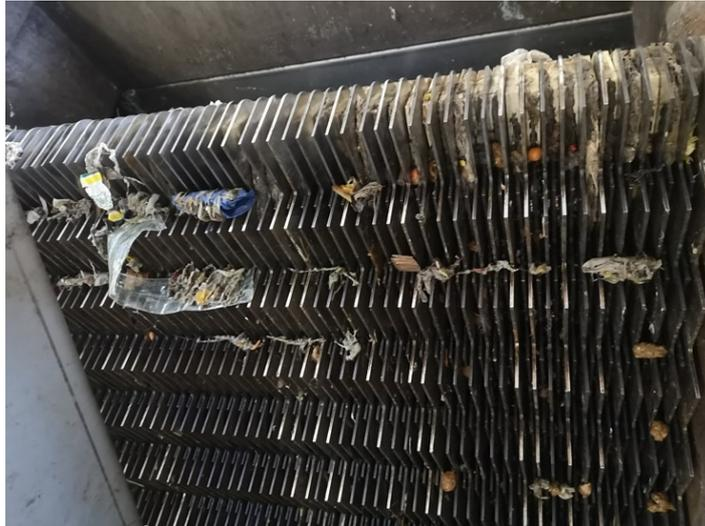
Abbildung 2.5: Stufenrechen in der kommunalen Kläranlage Jägersfreude.
