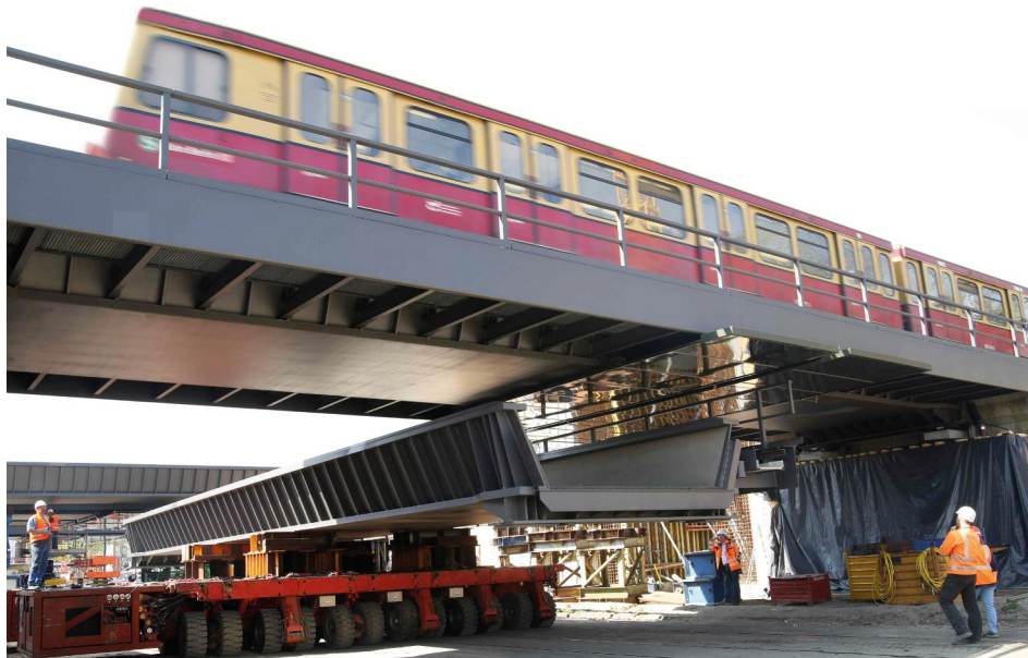
Abbildung 1.1: Transport des Überbaus einer Eisenbahnbrücke zu seinem Bestimmungsort am Sterndamm in Berlin (Bild: Sabine Gudath)
