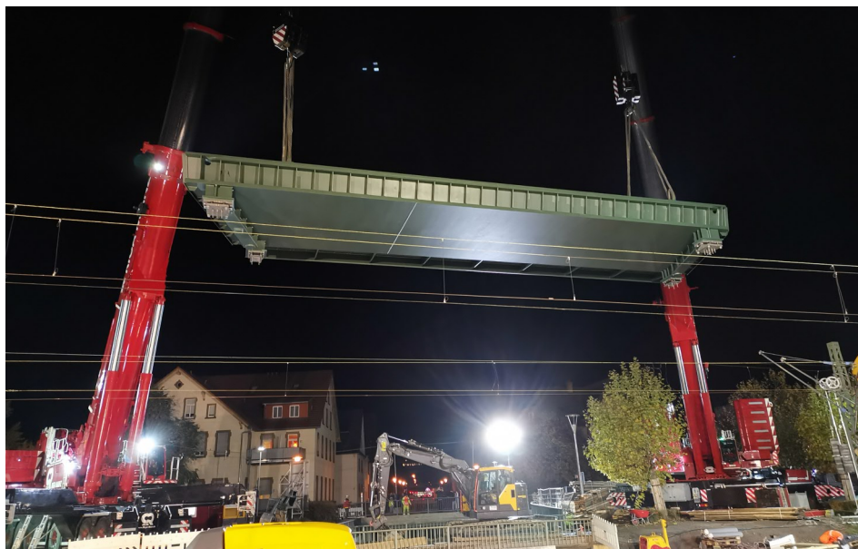
Abbildung 1.2: Einhub einer Trogbauwerkbrücke mit einer Dickblech-Fahrbahn in Heppenheim Ende 2019
