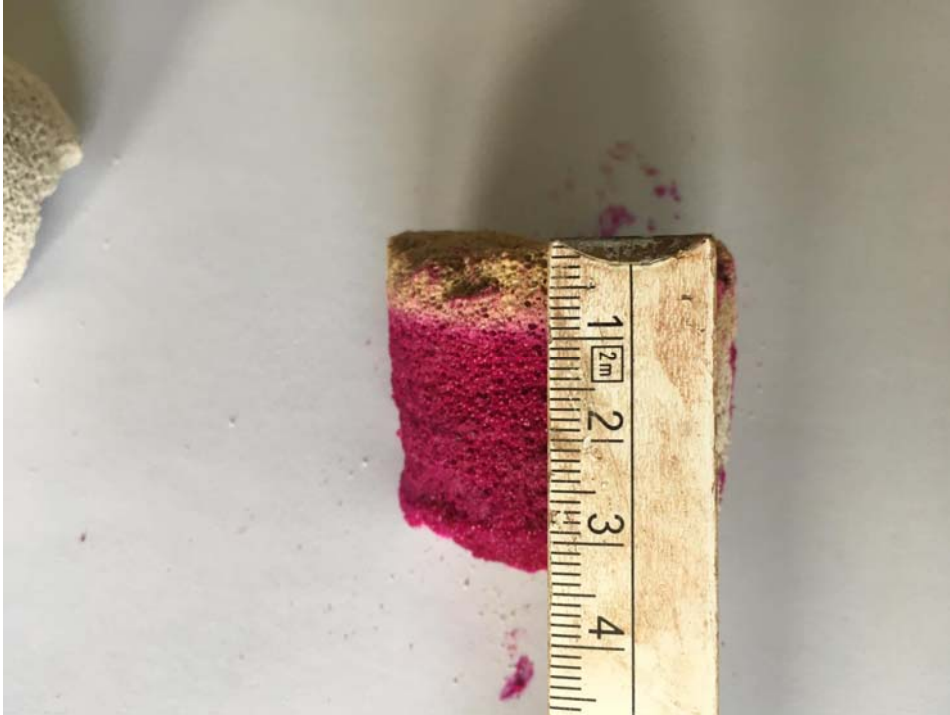
Abbildung 3.41 Carbonatisierungstiefe von 0,9 cm
