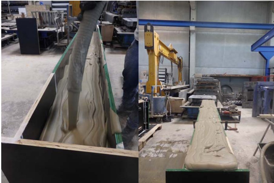
Abbildung 6.17 Einfüllen des Schaumes (links) und geringfügiges Überfüllen der Schalung mit Schaum (rechts)
