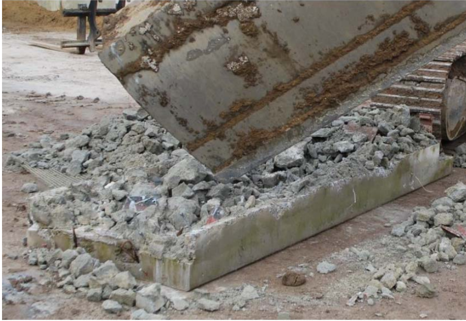
Abbildung 4.12 Trennprozess des mineralisierten Schaumes von der Betonoberfläche
