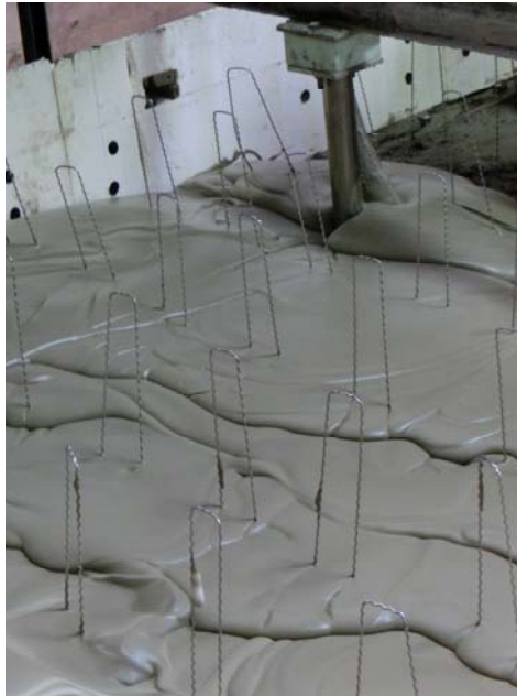
Abbildung 6.1 Aufbringen des mineralisierten Schaumes auf Pi - Platten Elemente aus Stahlbeton im Zuge der Fertigung für die ETA - Fabrik
