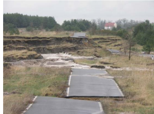
Abb. 2-33: Setzungsfließen infolge einer Bodenverflüssigung; KUDLA & SZCZYRBA et al. (2013)
