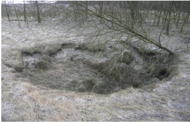
Abb. 2-32: Geländeeinbruch infolge einer Bodenverflüssigung; WITTIG (2016b)
