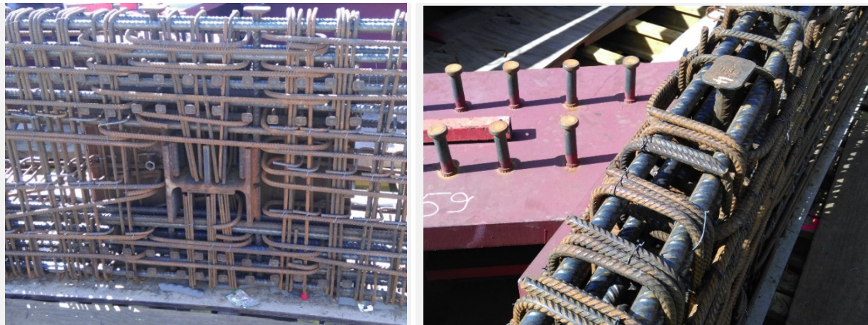
Abbildung 4-63: Bewehrungsführung eines Sichtbetonbauteils ohne Berücksichtigung der Verdichtung 406
