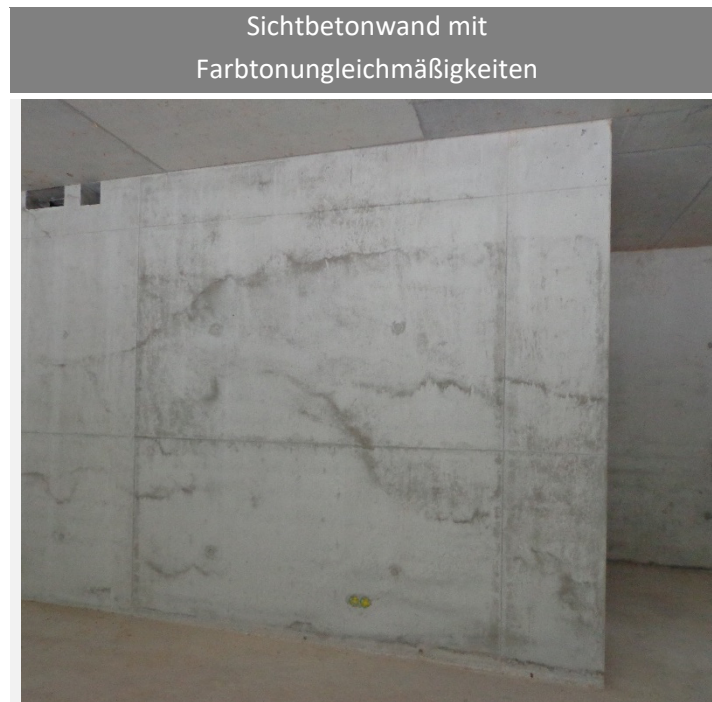
Abbildung 4-52: Sichtbetonwand mit Farbtonungleichmäßigkeiten
