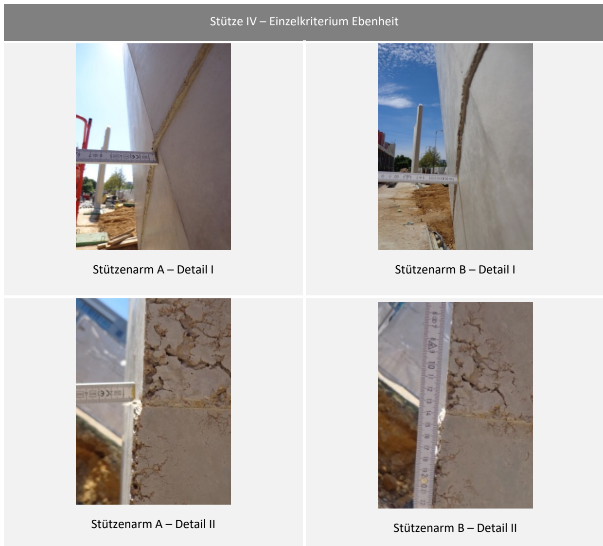
Abbildung 4-35: Stütze IV – Einzelkriterium Ebenheit
