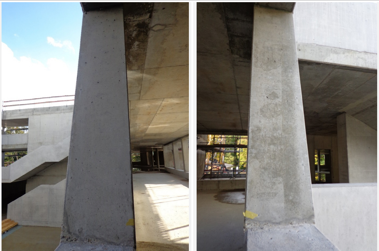
Abbildung 4-31: Ansichten der geneigten Sichtbetonflächen der Stützen 1. OG Achse G9
