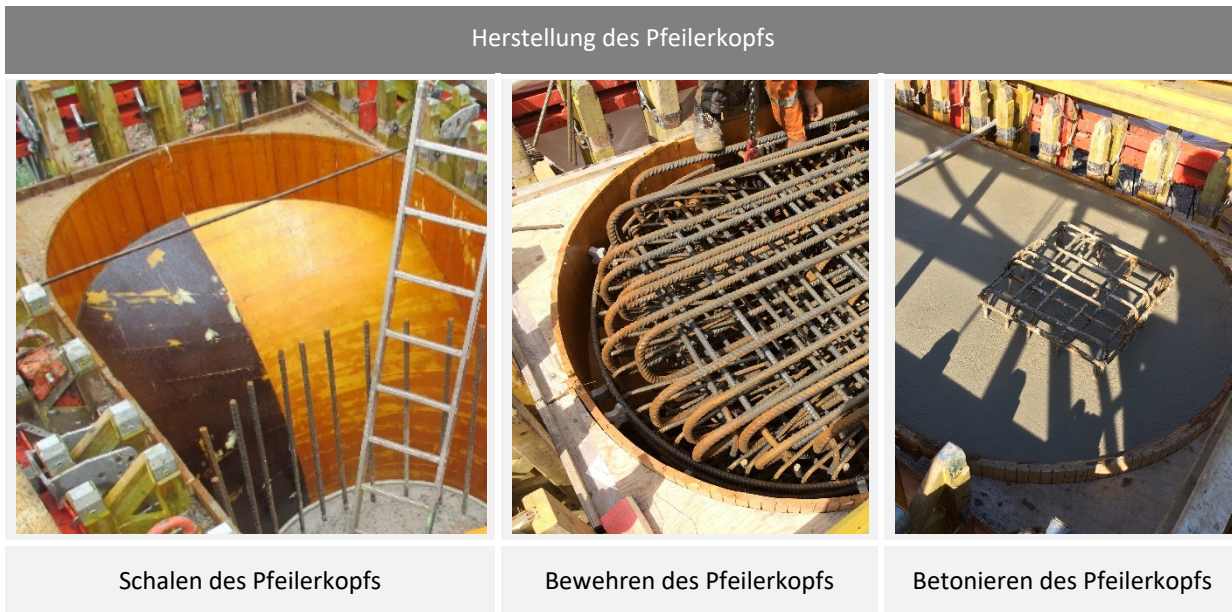
Abbildung 4-41: Darstellung der wesentlichen Arbeitsschritte zur Herstellung eines Pfeilerkopfs 342
