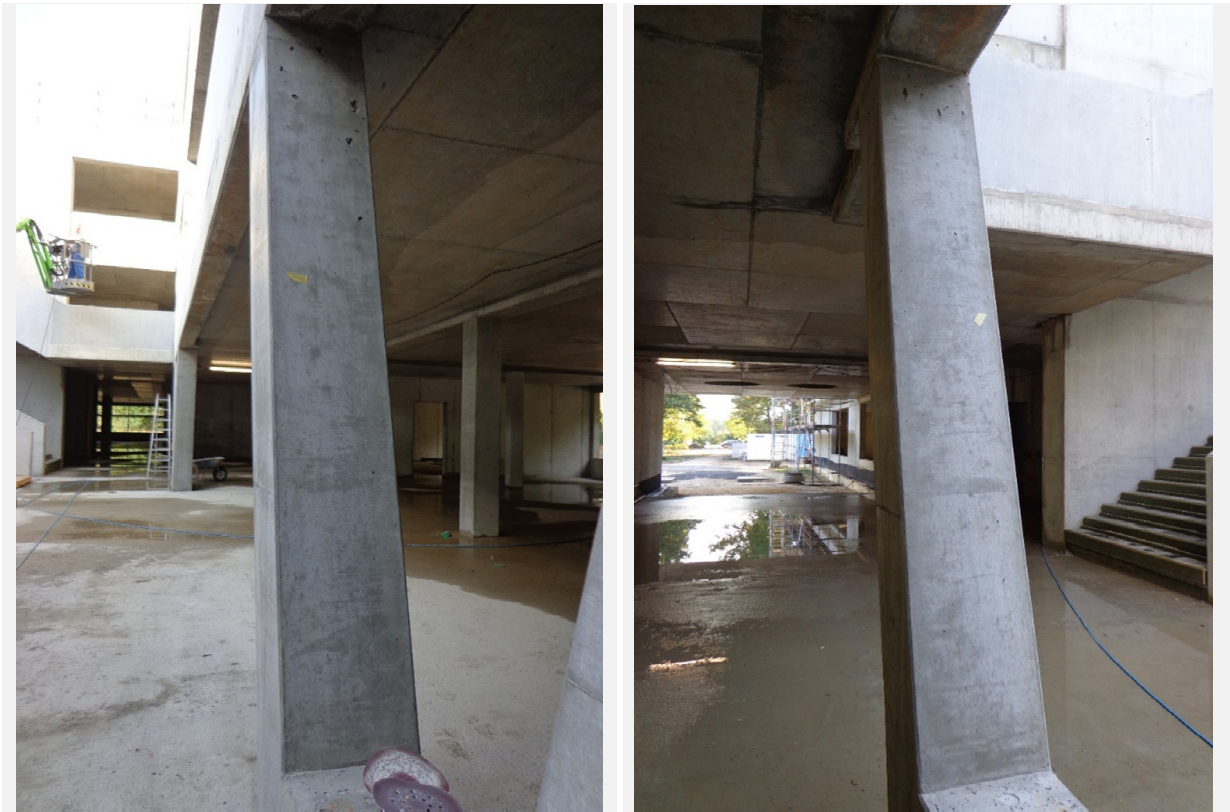
Abbildung 4-29: Ansichten der geneigten Sichtbetonflächen der Stütze EG Achse D7
