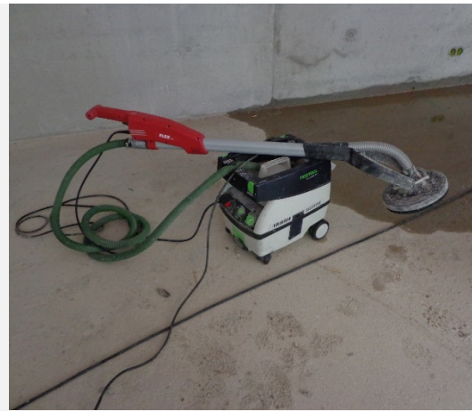
Abbildung 4-55: Schleifen von Sichtbetonbauteilen, Arbeitskraft und Betriebsmittel
