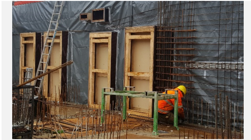
Abbildung 4-67: Schalung und Bewehrung eines Sichtbetonbauteils mit Einbauteilen
