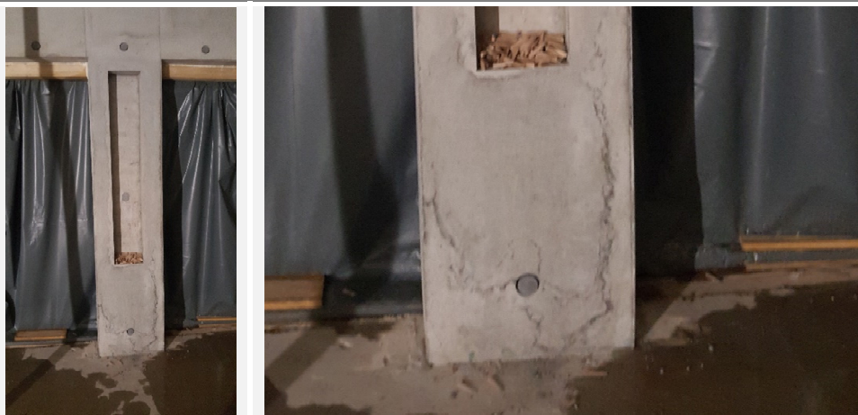
Abbildung 4-68: Sichtbetonbauteil mit mehreren Aussparungen und Einbauteilen
