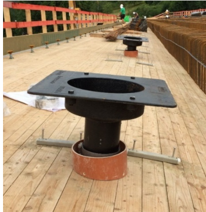
Abbildung 4-46: Entwässerungstopf auf der Schalungshaut 348
