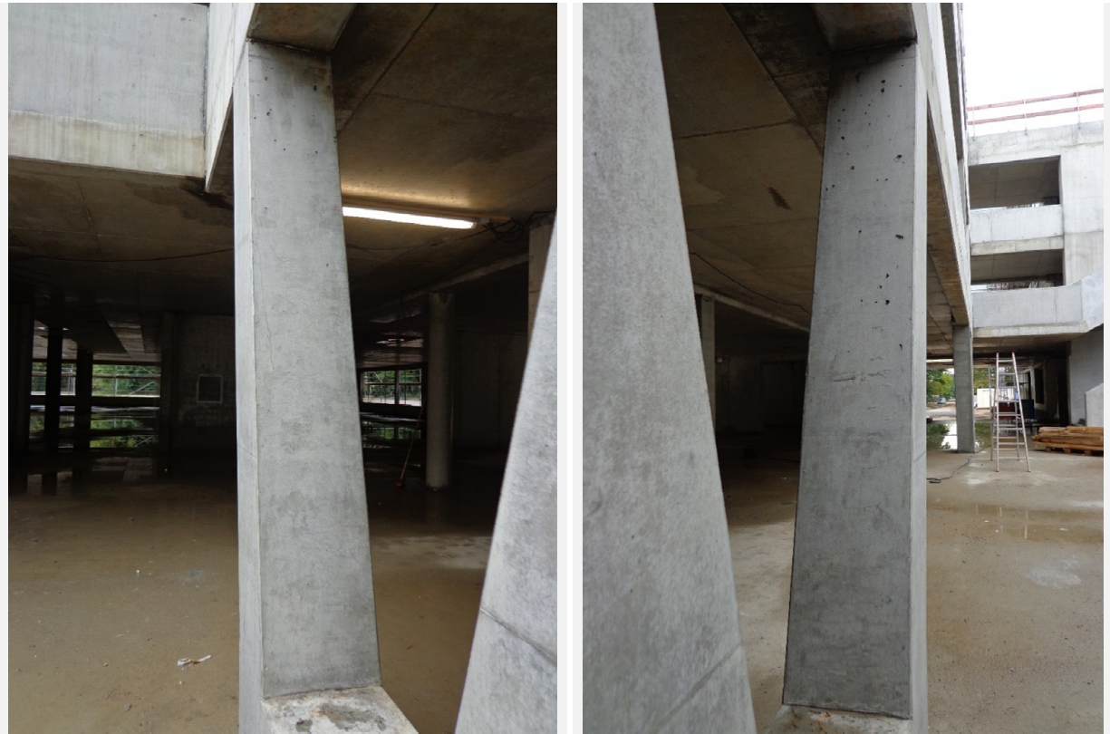
Abbildung 4-30: Ansichten der geneigten Sichtbetonflächen der Stütze EG Achse D9
