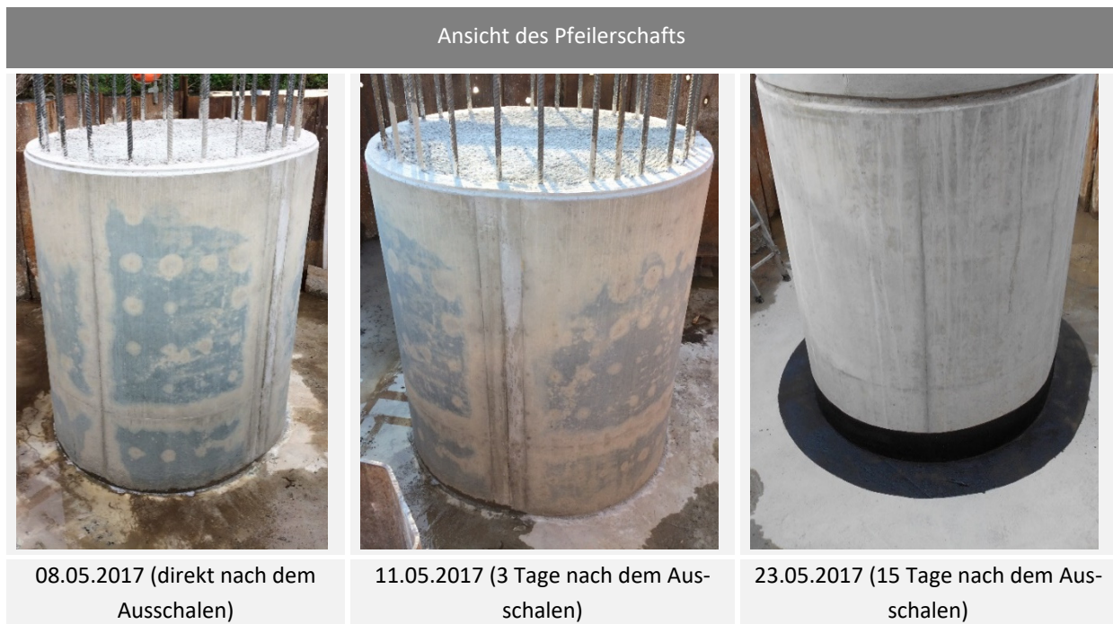
Abbildung 4-42: Entwicklung der Ansicht des Pfeilerschafts 343
