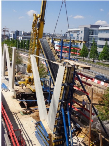
Abbildung 4-39: Ausschalen einer komplex geneigten Sichtbetonstütze
