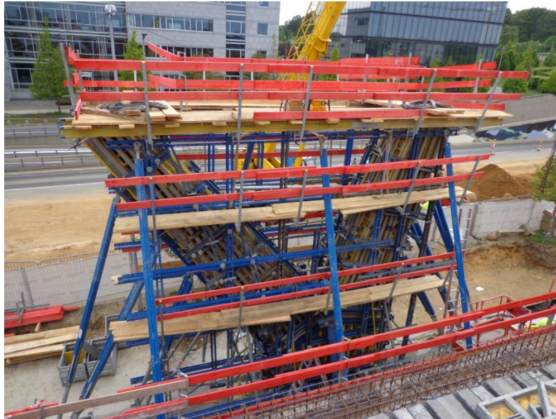
Abbildung 4-38: Einschalen einer komplex geneigten Sichtbetonstütze
