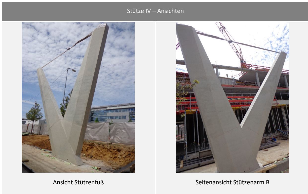
Abbildung 4-33: Ansichten Stütze IV – einen Tag nach dem Ausschalen
