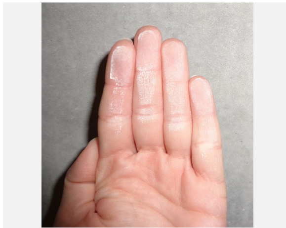
Abbildung 4-57: Schleifstaub auf der Sichtbetonwand nach dem Schleifen
