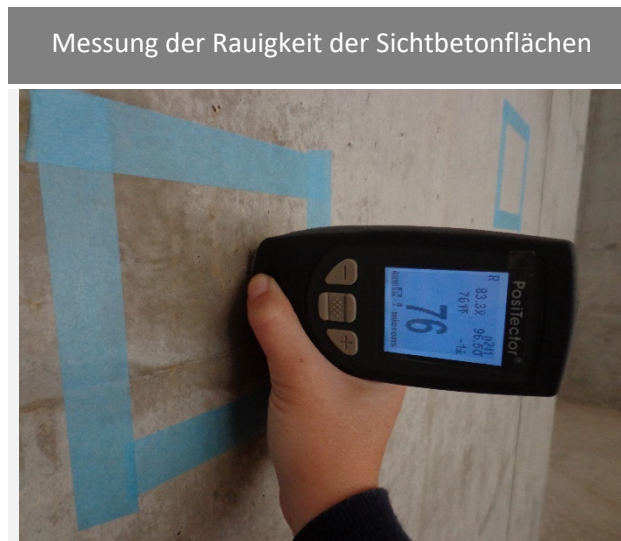
Abbildung 4-54: Messung der Rauigkeit der Sichtbetonflächen
