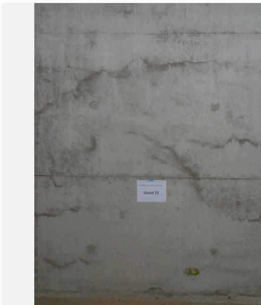
Abbildung 4-56: Sichtbetonwand vor und nach dem Schleifen
