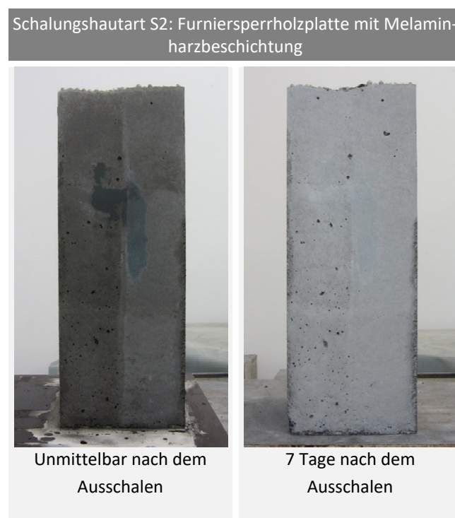
Abbildung 4-13: Entwicklung der Sichtbetonfläche geschalt mit der Schalungshautart S2 285
