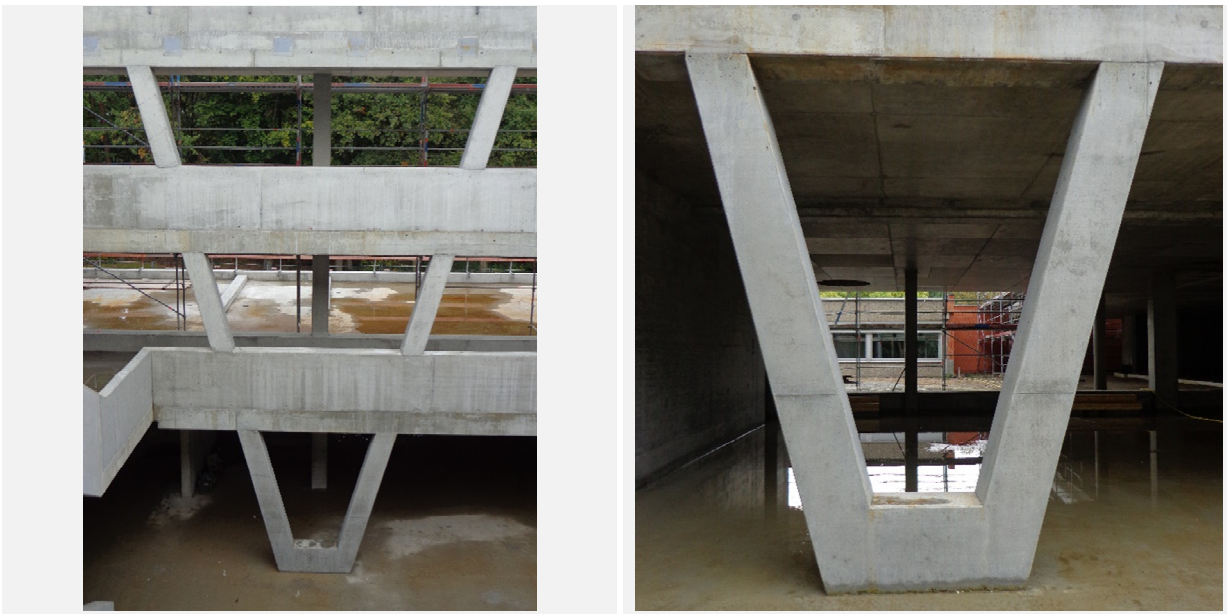
Abbildung 4-28: Ansichten der geneigten Sichtbetonstützen
